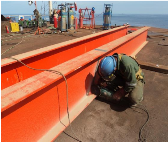
El trabajador utilizando su Equipo de Protección Personal (EPP).
