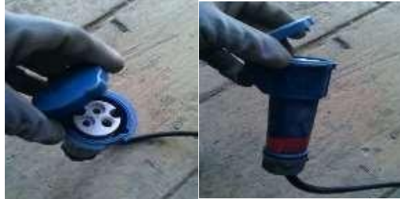
Figura N°30. Cambio de tomacorrientes.
