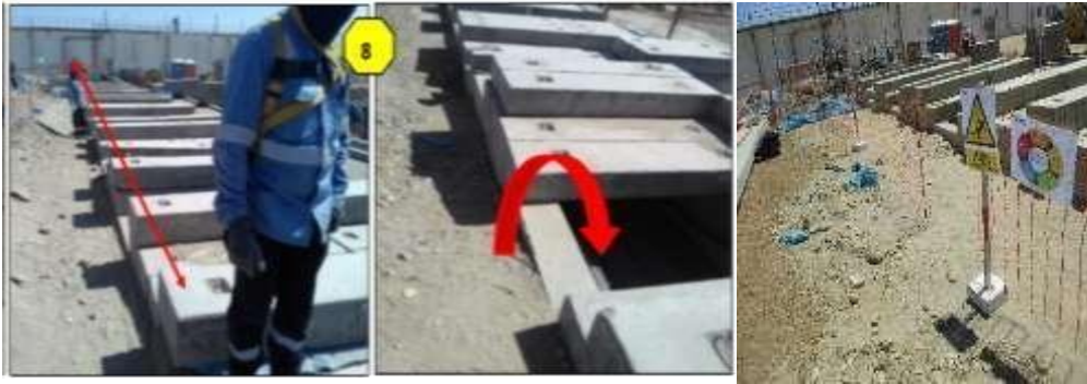
Figura N°06. Señalización de área de trabajo. Fuente: Elaboración propia.
