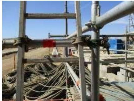
Figura N°38. Instalación de abrazadera.
