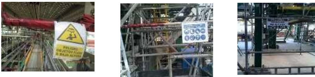
Figura N°18. Imposición de material informativo para la identificación de riesgos laborales.
