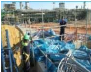
Figura N°36. Instalación de brandas rígidas. Fuente: Elaboración propia.
