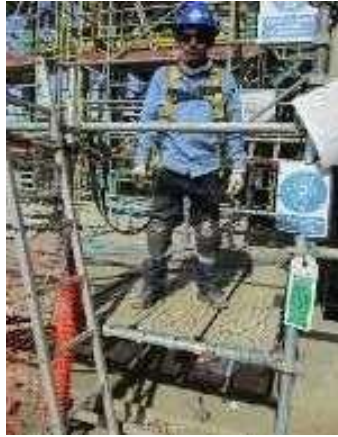
Figura N°14. Trabajo en andamios. Fuente: Elaboración propia.
