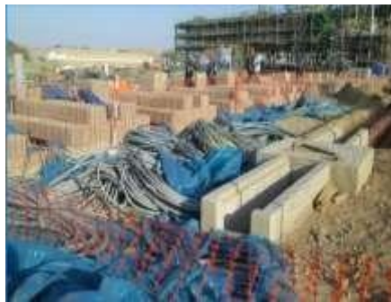
Figura N° 16. Trabajo de prevención de balizado de malla. Fuente: Elaboración propia.
