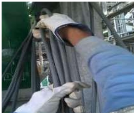
Figura N°19. Trabajos con cable eléctrico. Fuente: Elaboración propia.
