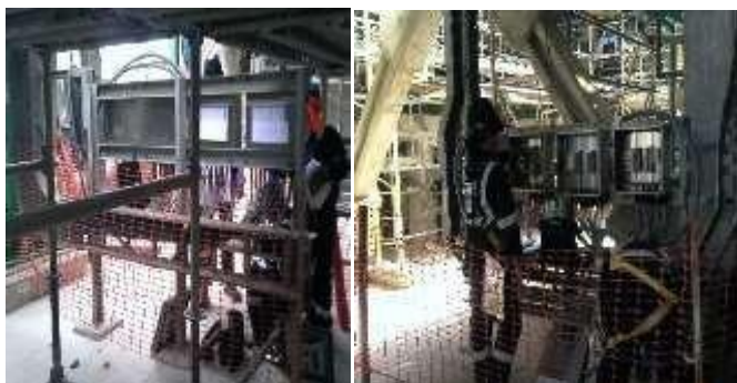
Figura N°37. Labores de conexión. Fuente: Elaboración propia.
