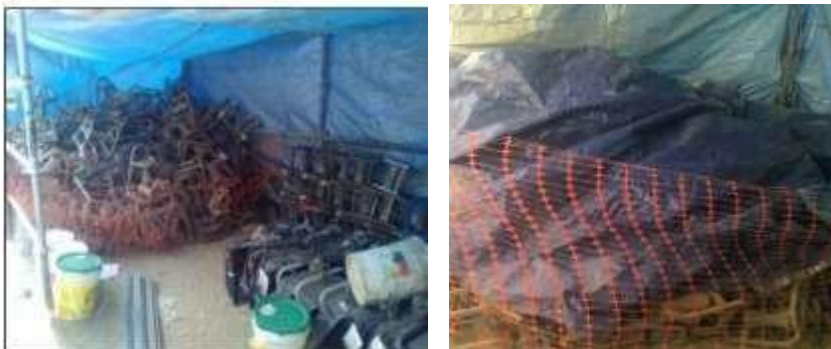
Figura N°23. Trabajos de limpieza y orden de polines. Fuente: Elaboración propia.
