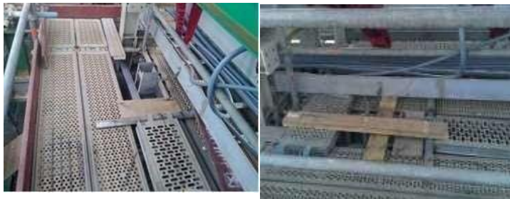
Figura N°34. Observación de andamios. Fuente: Elaboración propia.
