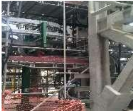
Figura N°03. Actividad en proceso.
