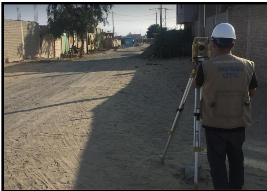
Foto N°23: Levantamiento Topográfico con estación total.
