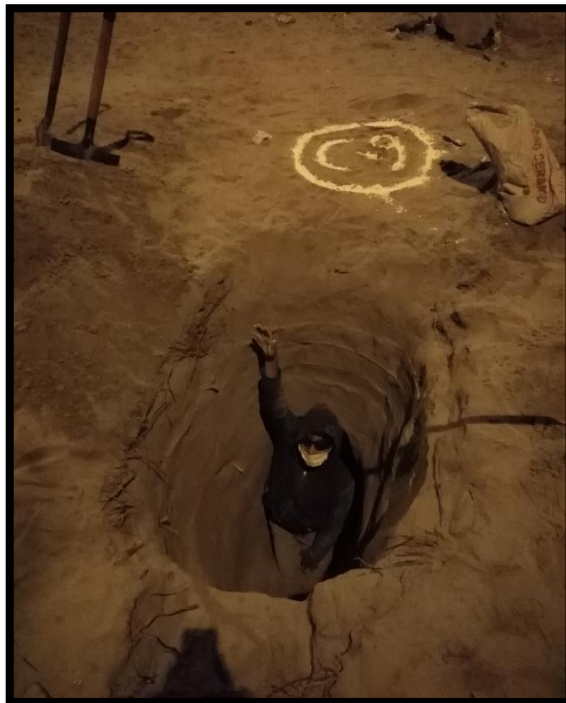
Foto N°15: En la calicata C-9, de 0.00 a 0.10 se tiene un estrato de relleno de afirmado, de 0.10 a 3.00, arena de grano gruesa a fina, densidad semicomcompacta, ligeramente húmeda, color beige claro (SP)
