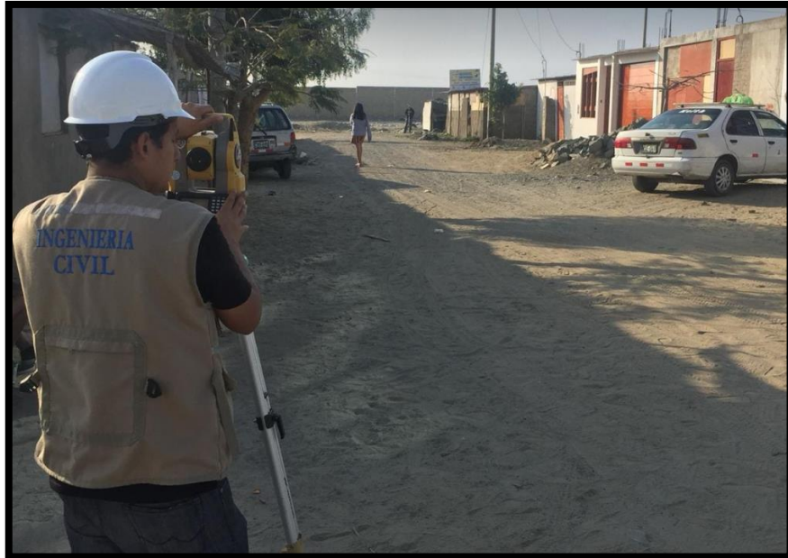
Foto N°22: Levantamiento Topográfico con estación total.
