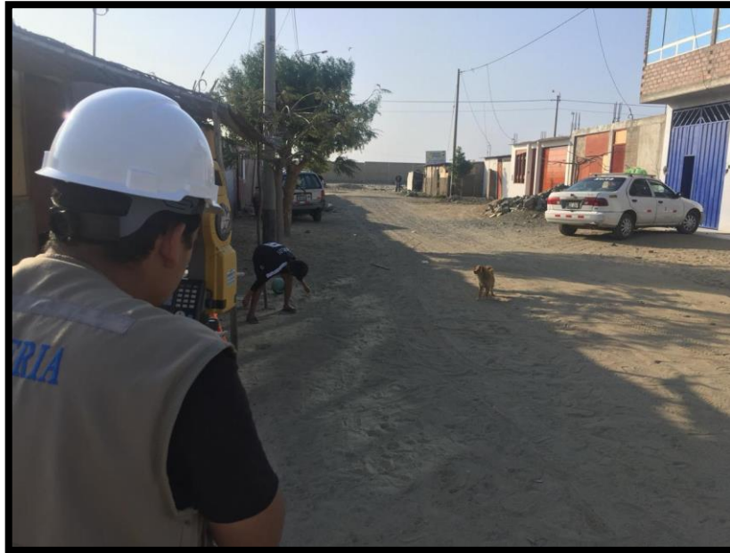
Foto N°24: Toma de puntos para el levantamiento topográfico
