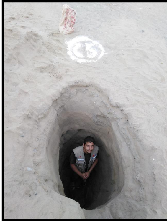
Foto N°12: En la calicata C-7, de 0.00 a 0.10 se tiene un estrato de relleno de afirmado, de 0.10 a 3.00, arena de grano gruesa a fina, densidad semicomcompacta, ligeramente húmeda, color beige claro (SP)
