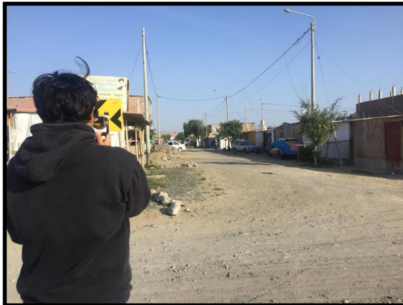
Foto N°25: Toma de puntos para el levantamiento topográfico
