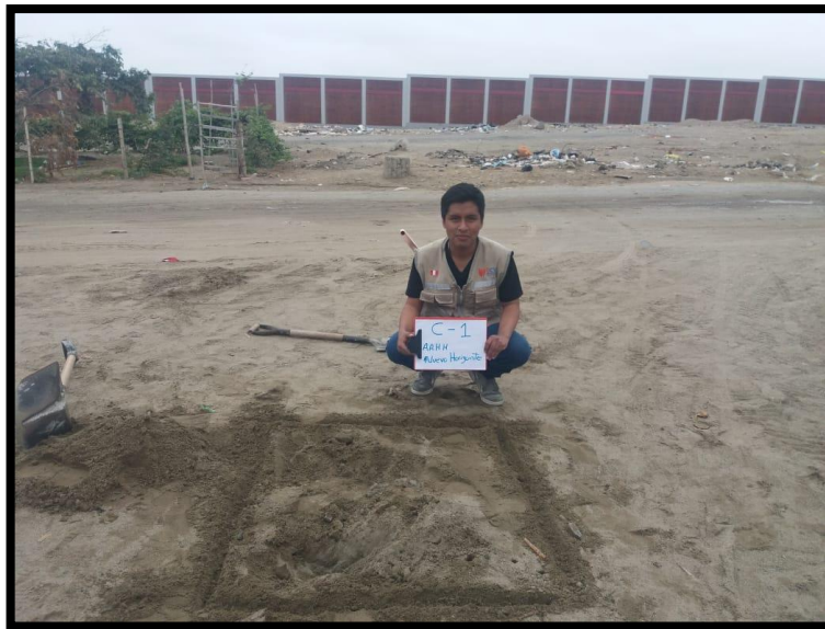
Foto N°1: Ubicación de Calicata C-1
