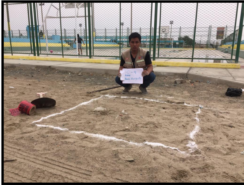
Foto N°7: Ubicación de Calicata C-4
