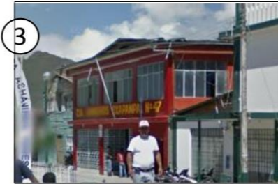
3 ESTACIÓN DE BOMBEROS
