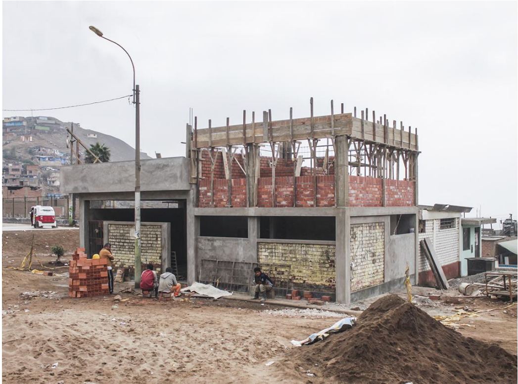
Figura 69. Proceso de construcción del centro Comunal “Fitekantropus”. Recuperado de: https://www.archdaily.pe/pe/870468/local-comunal-del-comedor-san-martin-proyecto-fitekantropus
