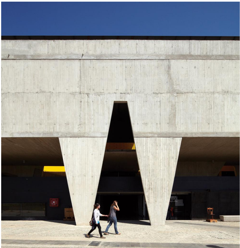
Figura 35. Acabo en hormigón expuesto en la fachada. Recuperado de: https://www.archdaily.pe/pe/02-206232/parque-cultural-valparaiso-hlps
