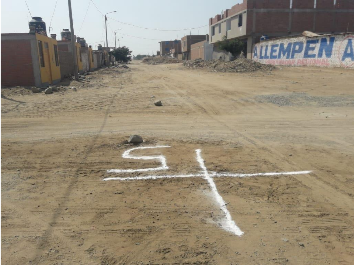
ANEXO 19: Colocación de puntos de control
