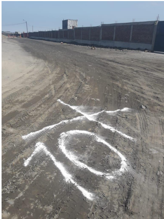
ANEXO 20: Colocación de puntos de control
