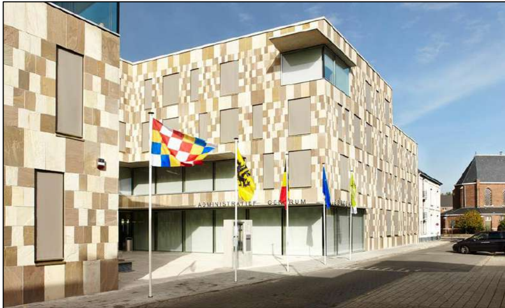
. Imagen: Vista de la calle al ayuntamiento . Fuente: Archdaily
