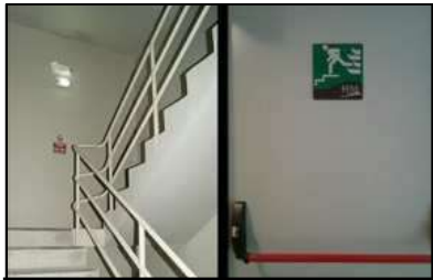
ESCALERA DE EMERGENCIA
