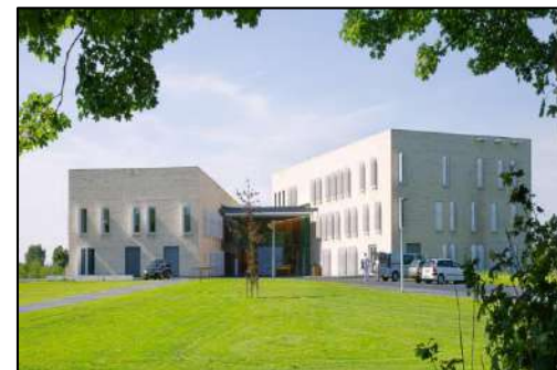
Imagen: Vista principal Ayuntamiento Brockhorst Fuente: Atelier Pro
