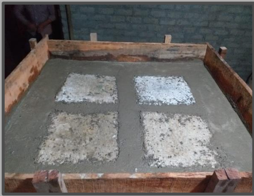
Figura N° 62: Vaciado de losa aligerada con ladrillos LDPE
