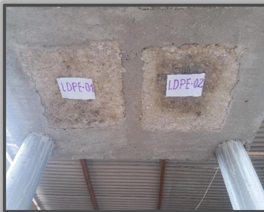
Figura N° 64: Vista inferior de losa aligerada elaborada con
