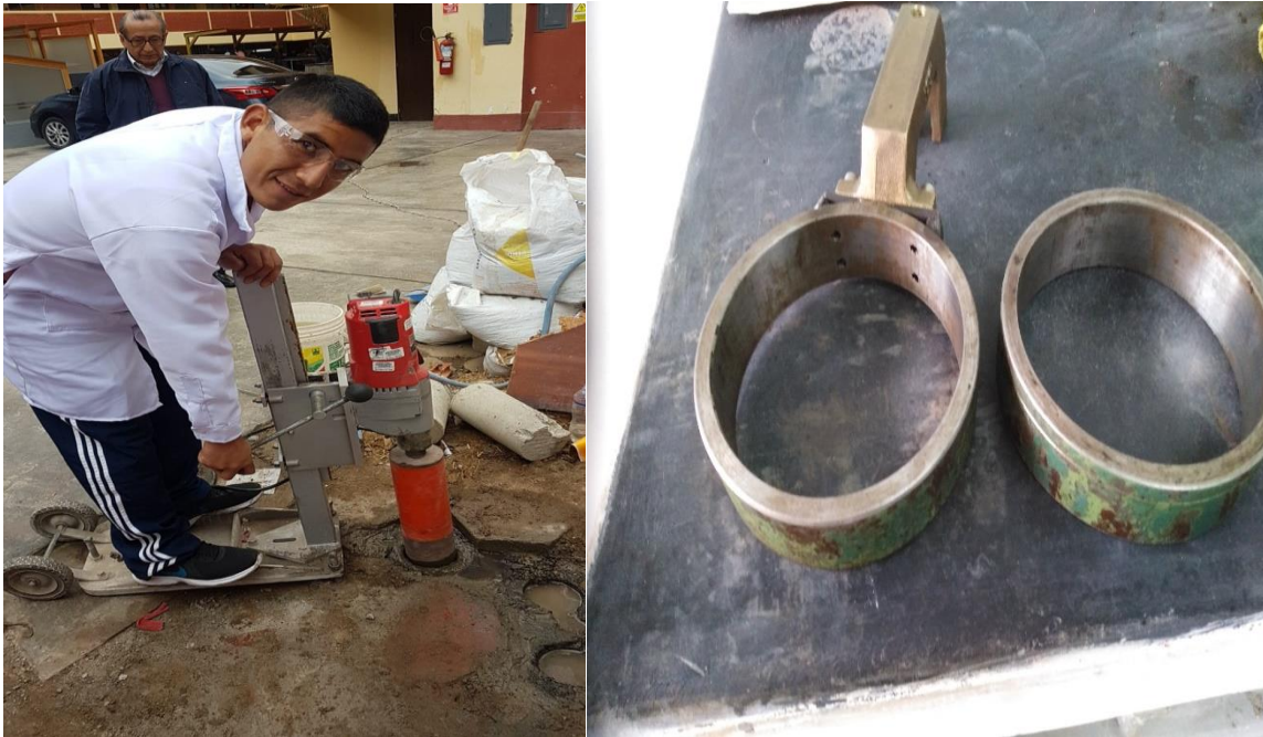
Figura N° 15: Extracción de pavimento antiguo con diamantina (izquierda) anillos construidos (derecha)
