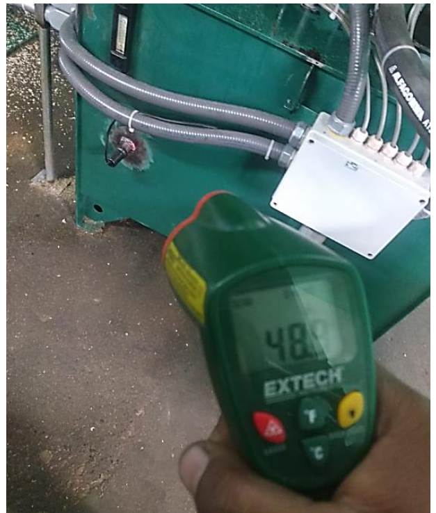
Figura 11: Realizando el diagnóstico de funcionamiento del intercambiador de calor.
