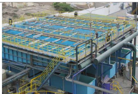
fig. 14: Recepción de trampas de grasa
