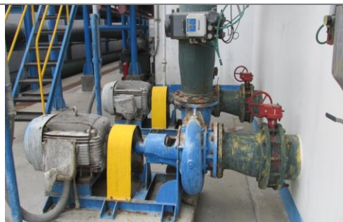
Fig. 13: Recepción de cisterna de almacenamiento
