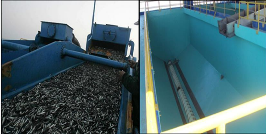
Fig. 11: Recepción de agua de bombeo
