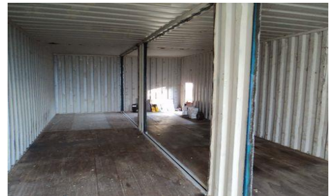
Figura N°31: Imagen de unión de contenedores
