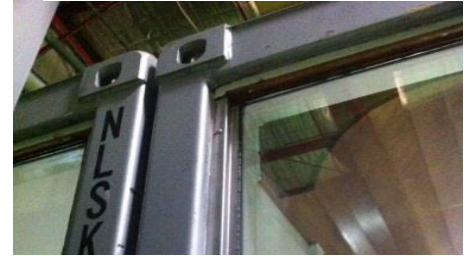
Figura N°29: Imagen de unión de contenedores
