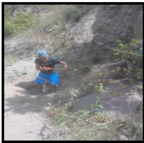
Figura 4. Excavación de calicata Fuente: Elaboración propia
