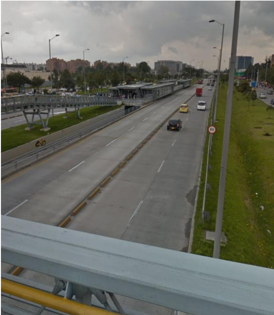
PARADERO DEL SISTEMA DE TRANSPORTE MASIVO - BOGOTA FUENTE: Google Maps
