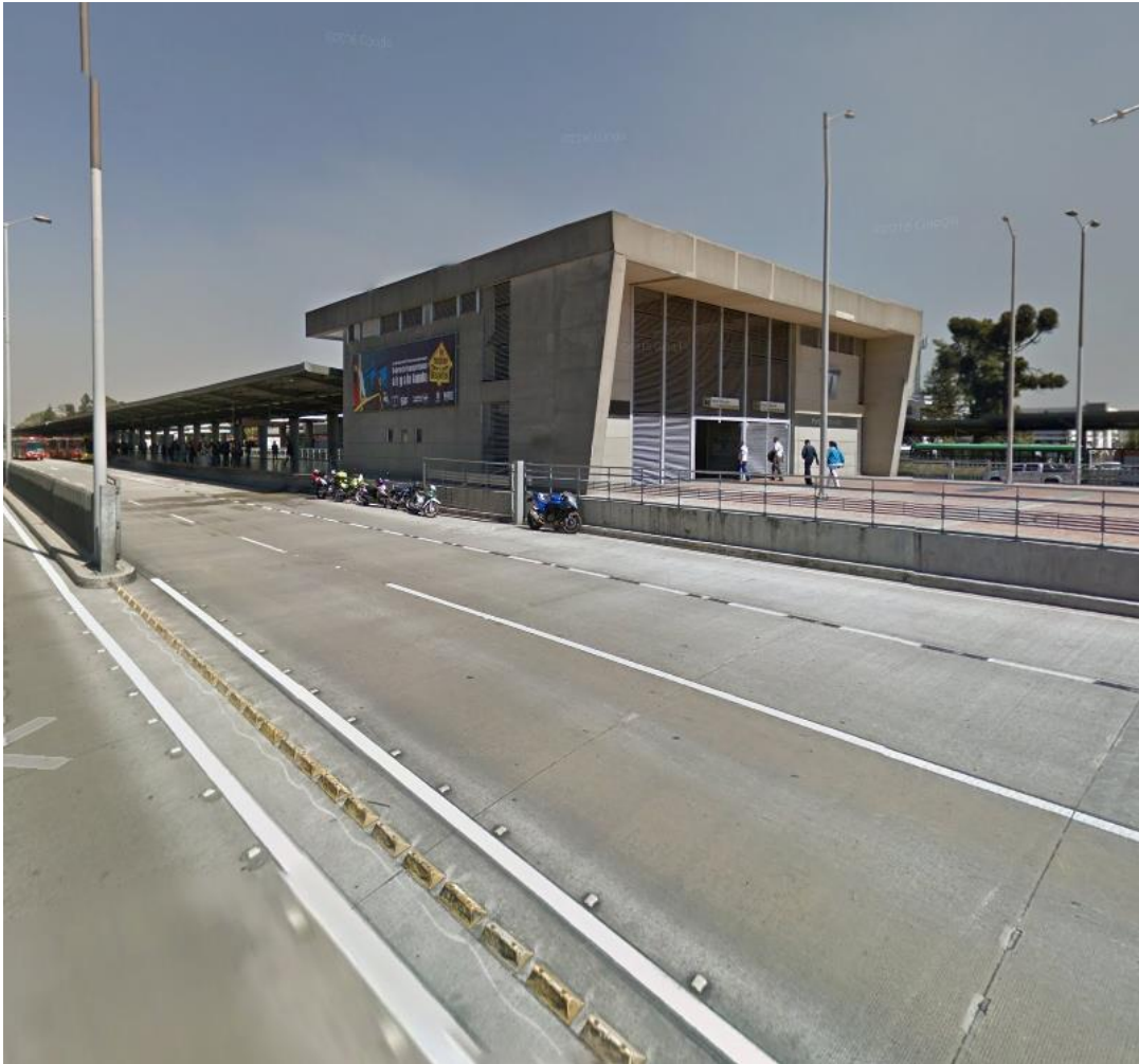
PARADERO DEL SISTEMA DE TRANSPORTE MASIVO - BOGOTA FUENTE: Google Maps
