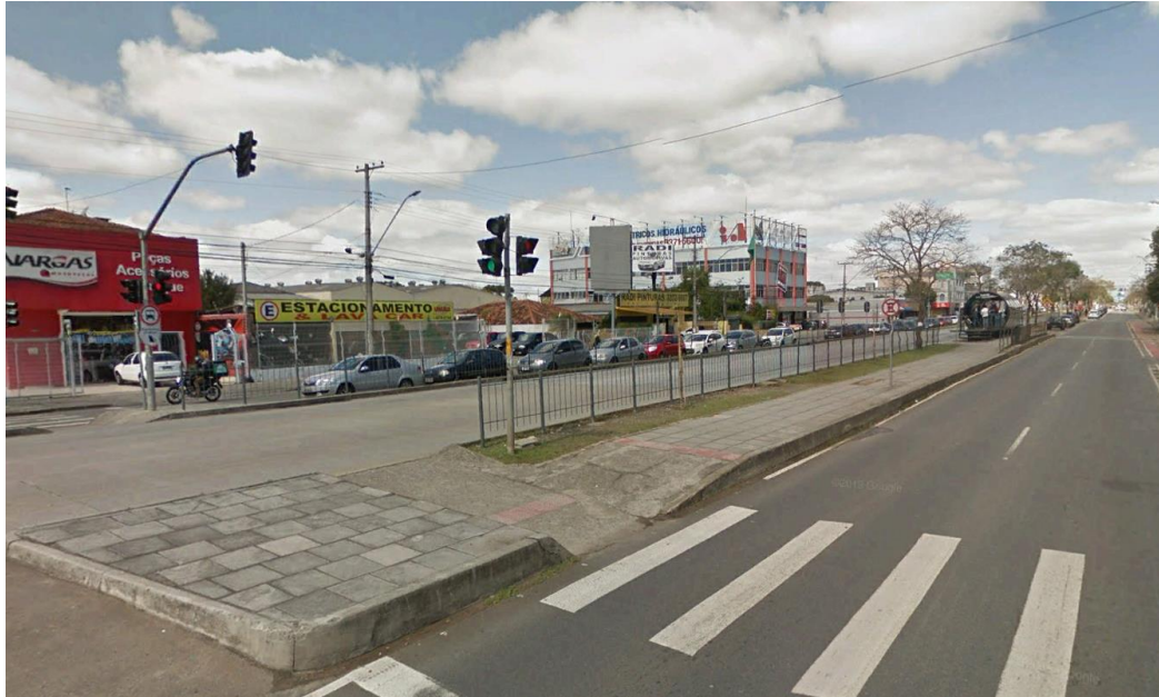
PARADERO TUBULAR DEL SISTEMA DE TRANSPORTE MASIVO – CURITIBA – AV. REPUBLICA ARGENTINA FUENTE: Google Maps
