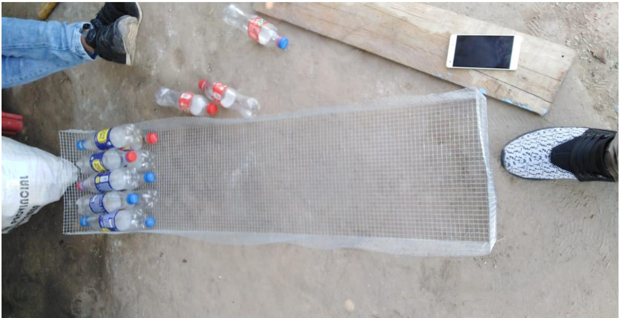
Figura 4: Elaboración de la malla para el bloque de 1.2x0.3x0.15 m.
