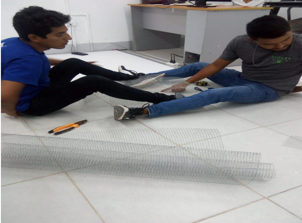
Figura 5: Elaboración de la armadura con malla para el bloque de 0.22x0.15x0.30 m.
