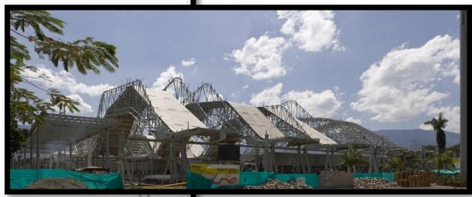
Cada cercha en sus extremos se apoya en tríos de columnas metálicas, localizadas detrás de las graderías, en las zonas exteriores de cada coliseo. Los pórticos conformados, permiten vencer las luces de 65 y 85 metros cubriendo los espacios de las canchas, las graderías y las circulaciones laterales a las mismas. Entre franjas hay unas canoas que recogen el agua y dilatan las franjas, permitiendo la entrada de luz filtrada a través de cerramientos laterales en policarbonato opalizado.
