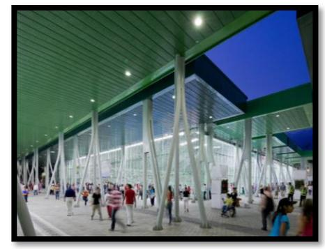
Las la forma de los edificios viene definida por la estructura misma, y para esto se opta por una estructura modular en acero que permite optimizar el proceso de fabricación y montaje. la estructura de cubierta se plantea en cerchas metálicas en celosía
