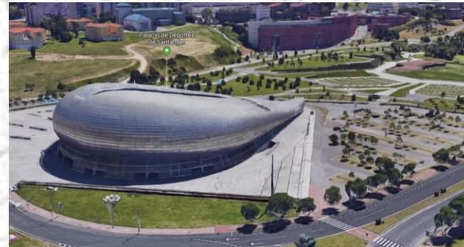
El perímetro del edificio está recorrido en su parte inferior por un muro cortina acristalado
