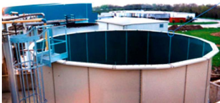
Figura 4. Tanque cilíndrico vertical sin techo.
