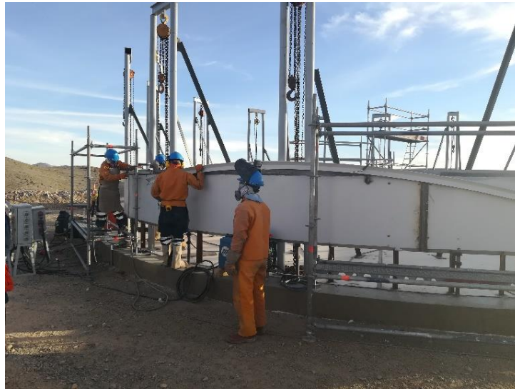
Figura 47. Armado anillo de rigidez.
