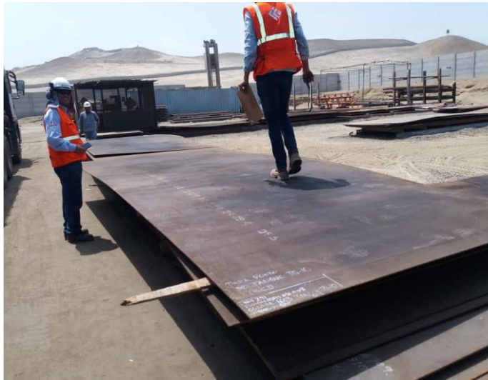
Figura 24. Inspección e identificación de coladas de planchas.
