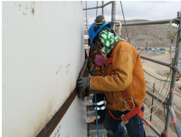
Figura 52. Inspección por prueba de vacío.
