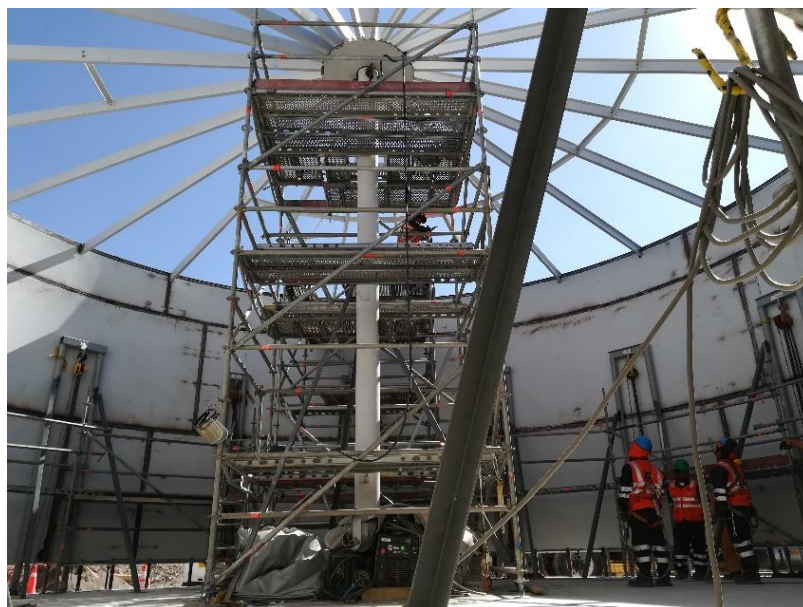
Figura 48. Instalación de columna central y vigas radiales.
