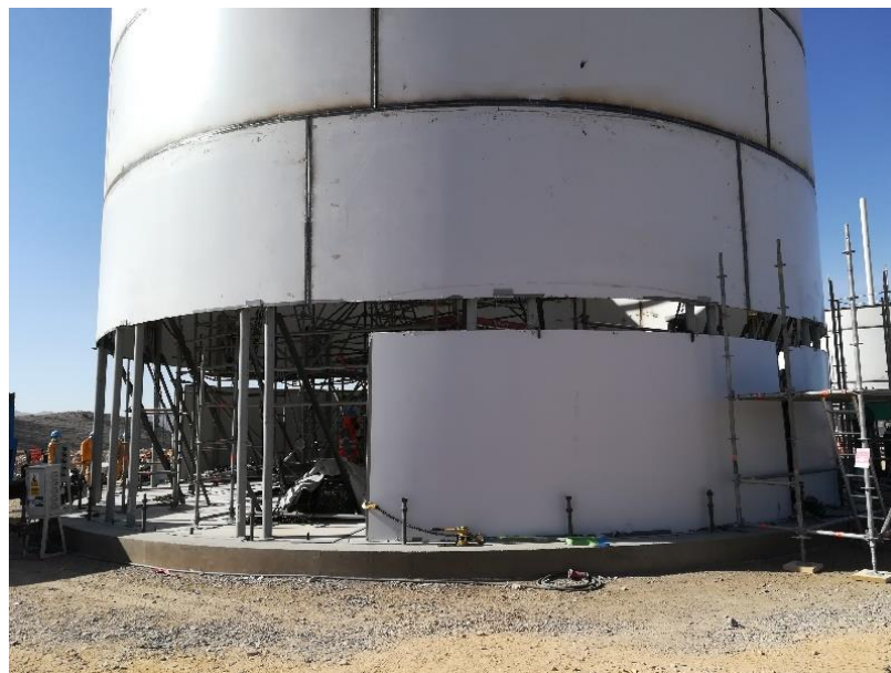
Figura 50. Instalación anillo inferior de tanque.
