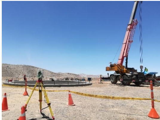
Figura 43. Traslado de planchas a zona de montaje.
