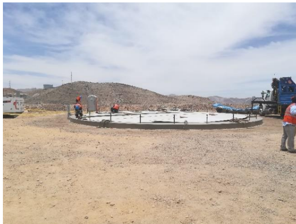
Figura 44. Armado de planchas de fondo.
