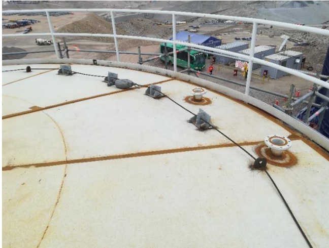
Figura 51. Instalación de boquillas.
