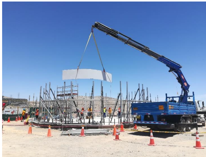
Figura 46. Armado de anillo superior.
