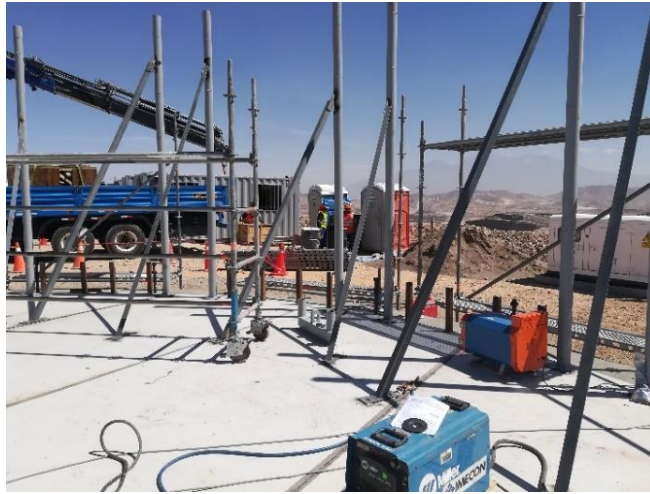
Figura 45. Instalación de estructuras temporales.
