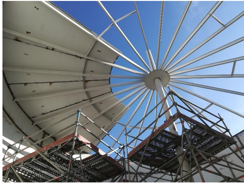
Figura 49. Instalación de planchas de techo de tanque.
