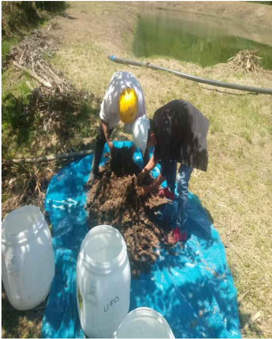
Imagen N° 5 y 6: aplicación de melaza y realización de la prueba del puño para la verificación del proceso.
