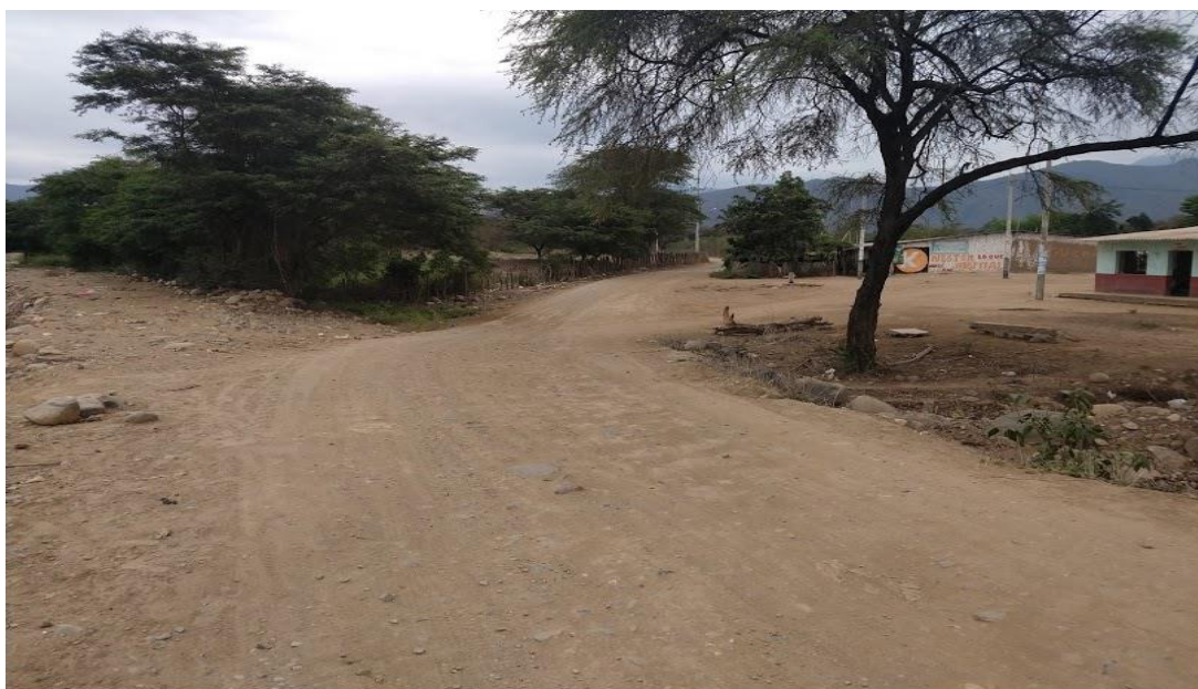
Ilustración 24. Vía con escasa señalización vertical y horizontal
