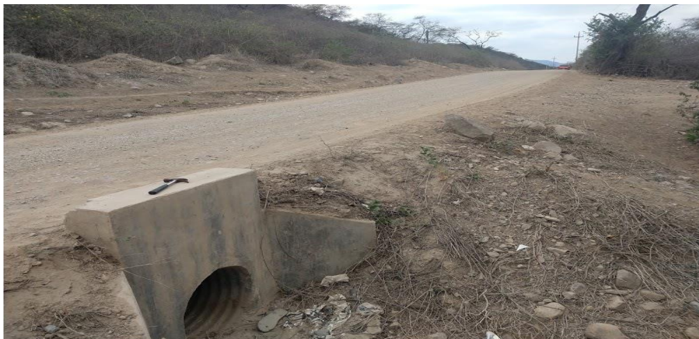
Ilustración 3. Obras de drenaje y alcantarilla
