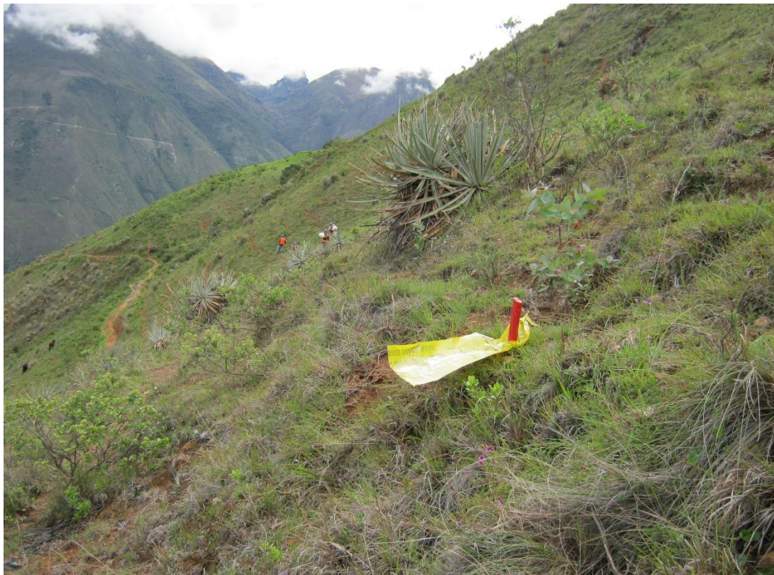
ESTACADO DEL TERRENO
