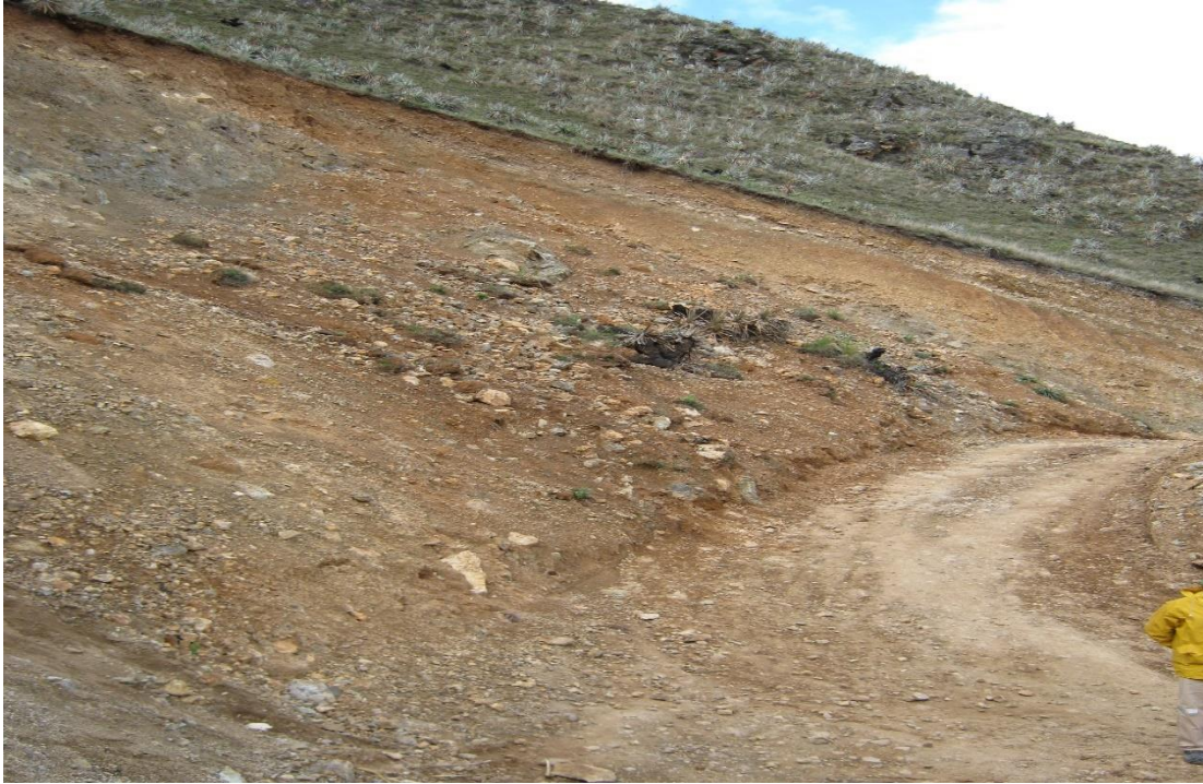
SITUACIÓN DE CARRETERA
