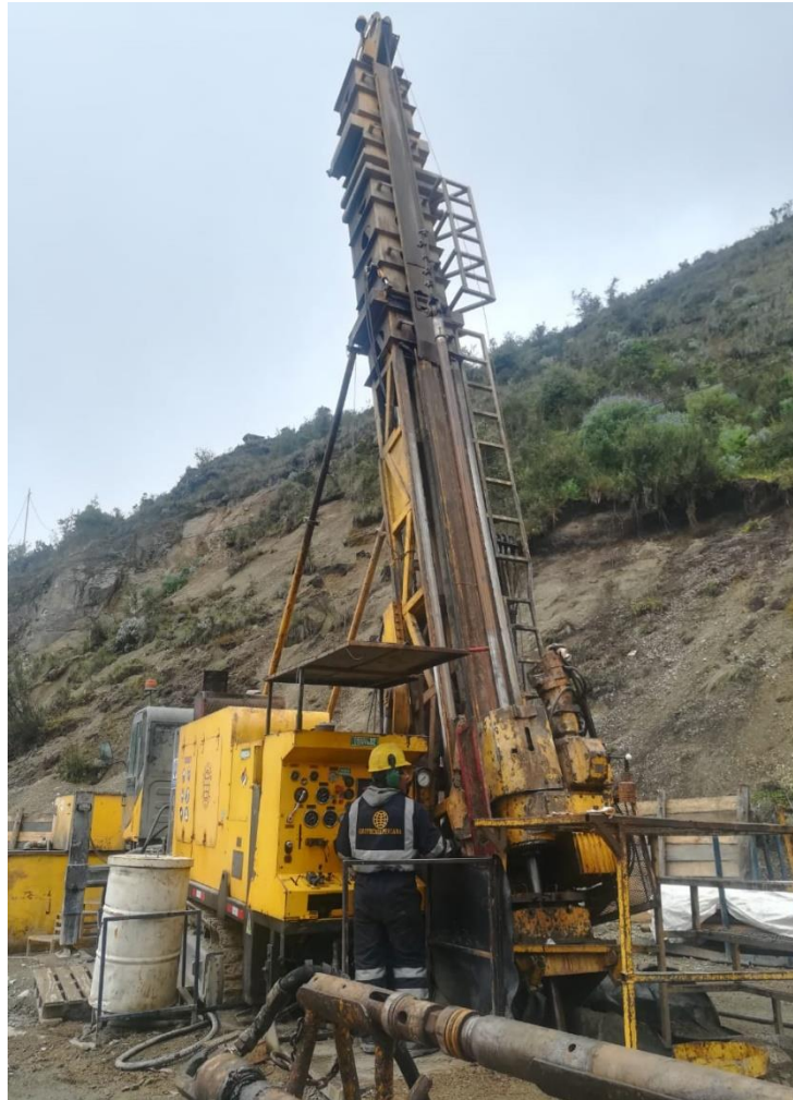
Figura 22. Perforadora CSD 3000 en operación
