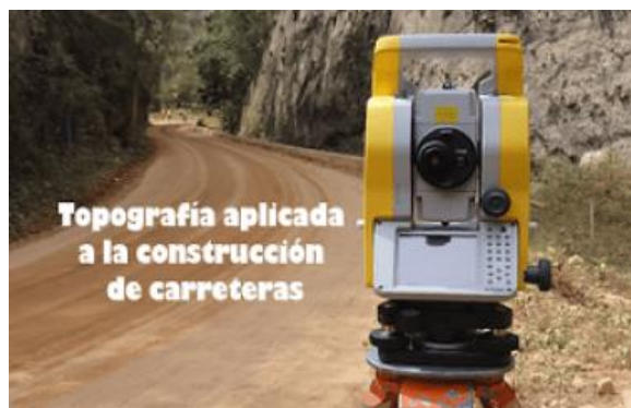
FIGURA N ° 7: Topografía en carretera
