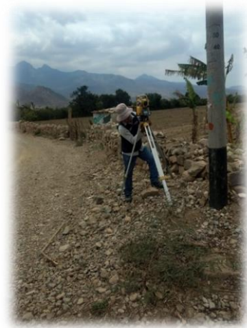
INSTALACIÓN DEL EQUIPO TOPOGRÁFICO
