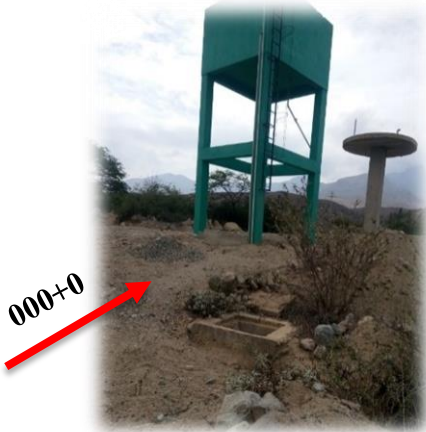
INICIO DE TRAMO 0+000 (CHAMAN)
