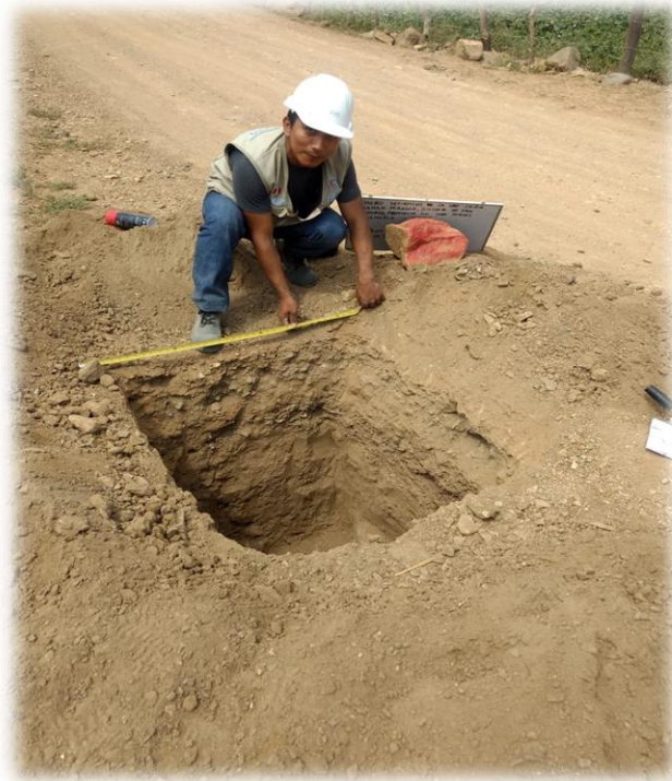
VERIFICANDO LAS MEDIDAS DE LA CALICATA
