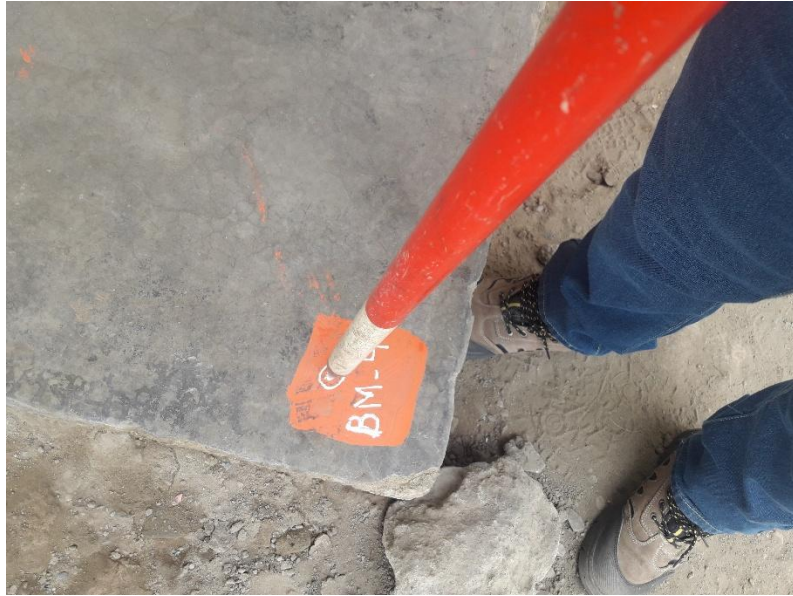
17.13.- Tomando puntos topográficos de la zona – AA. HH. El Mirador II
