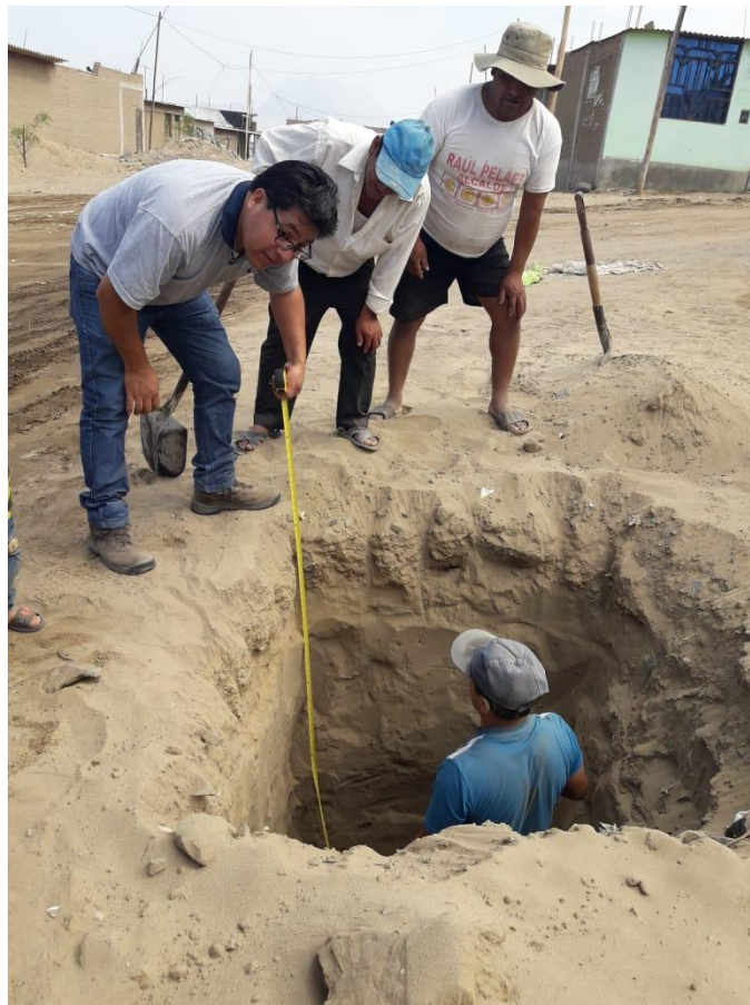
17.8.- Medición, excavación y sacado de muestra para calicatas – AA. HH. El Mirador II
