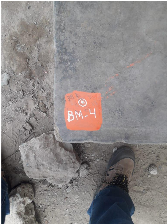
17.14.- Marcando los BM puntos topográficos de la zona – AA. HH. El Mirador II
