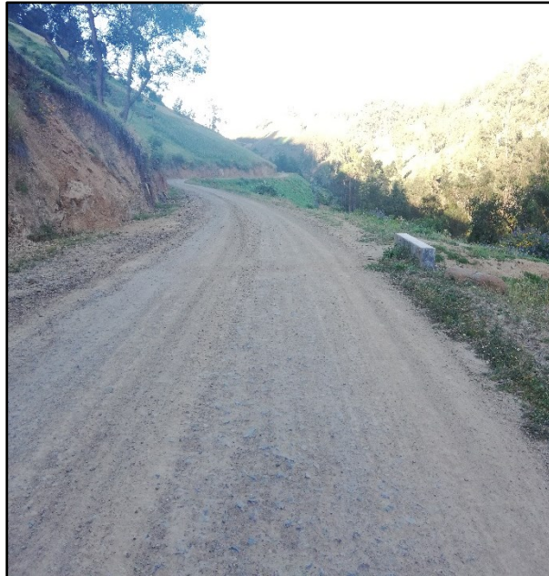
Figura 41: Carretera Sinsicap Fuente: Elaboración Propia
