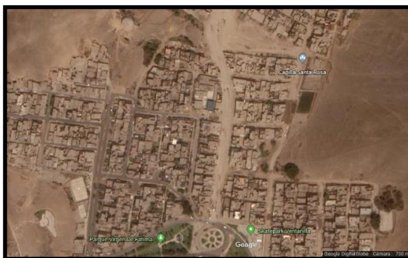
Figura N° 1: Urbanización Santa Rosa sin pavimento Fuente: https://bit.ly/2KEYvWR
