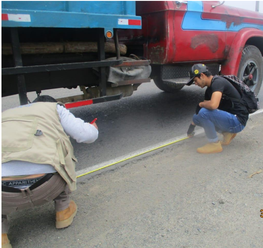
Fotografía 03: Marcado de puntos
