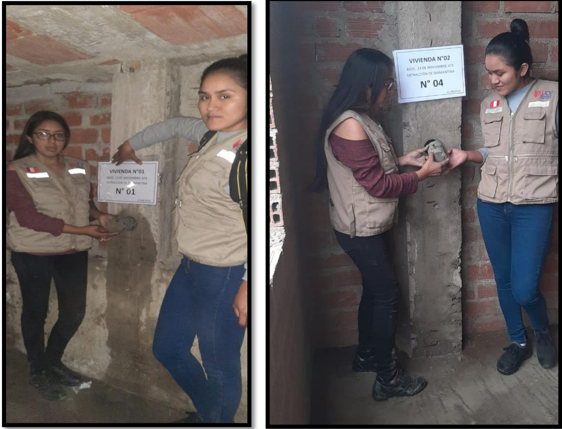
Figura 9. Extracción del espécimen de concreto endurecido. Fuente: elaboración propia.
