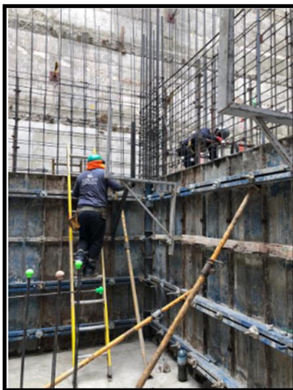
Foto 2 Encofrado de placa Sector 2
