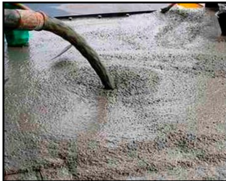
Figura 4: Vaciado de concreto en placa Fuente: Empresa Royal Sun Corporation
