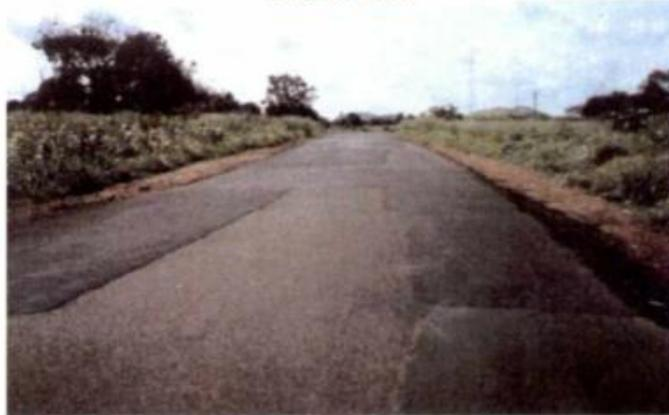
**Gravedad 3: Reparación de piel de cocodrilo o de fisuras longitudinales, en mal estado**
