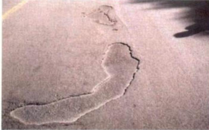
**Gravedad 2: Continuo sin aparición de la base granular o puntual con aparición de la base granular**
