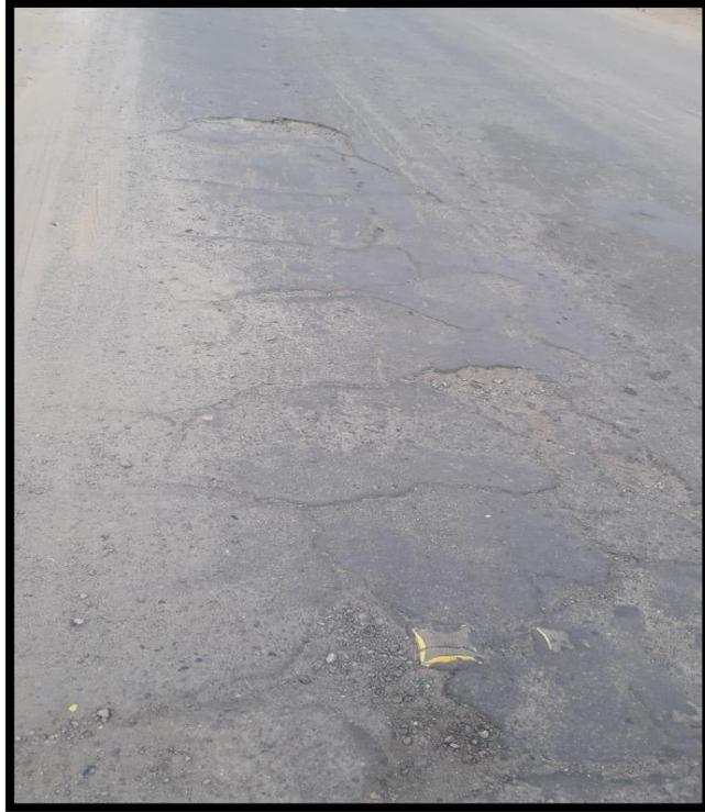
Identificación de patologías existentes (Agrietamiento en bloque)
