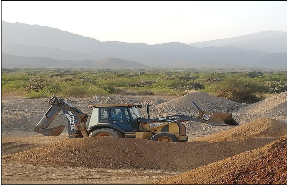
Imagen Nª3 Retroexcavadora John Deere 310K
