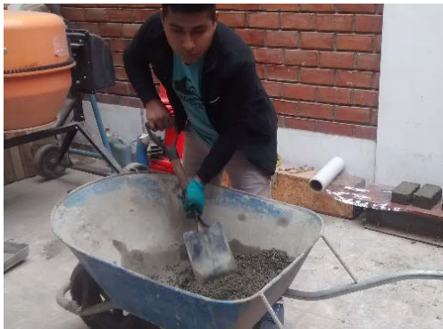
Figura N° 19. Mezclado del concreto.
