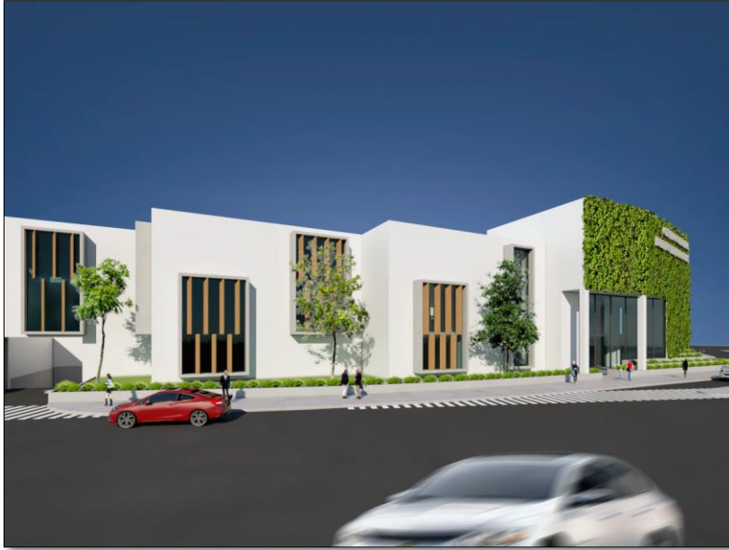
Figura 44. Imagen exterior del proyecto arquitectónico “CENTRO CULTURAL”
