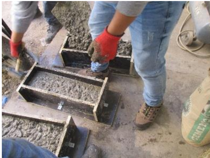
Figura N°44. Vaciado de mezcla a las probetas prismáticas
