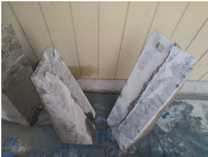
Figura N°47. Corte de las vigas alcanzadas sus 28 días de curado.
