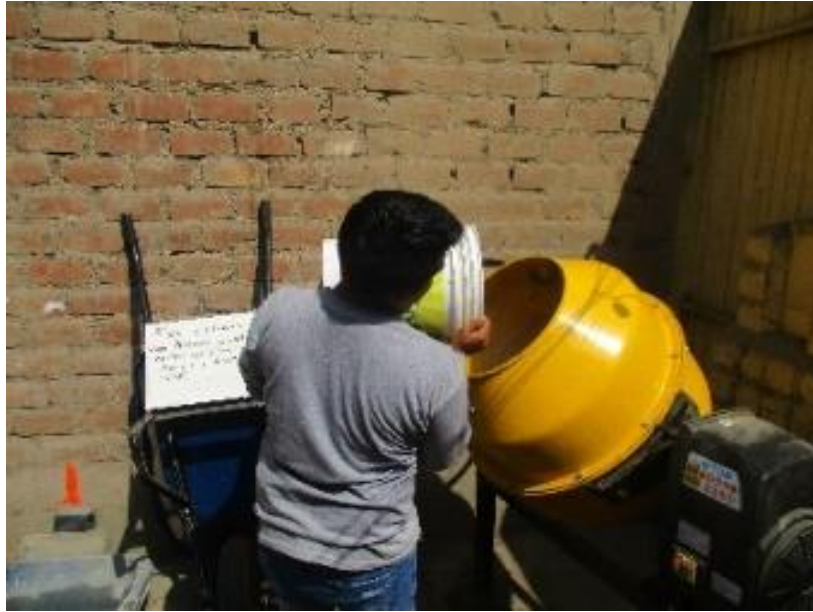
Figura N°40. Llenar al trompo con los agregados para hacer la mezcla.
