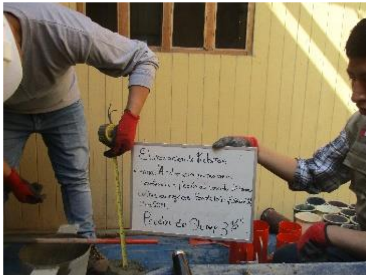
Figura N°43. Prueba de slump
