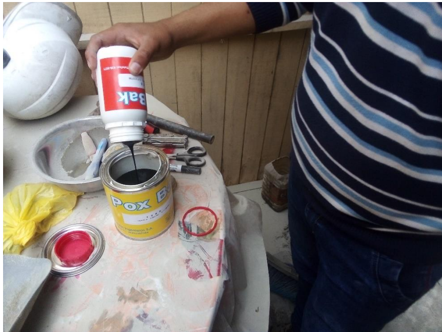
Figura N°48. Preparación de adhesivo poxbak 1580
