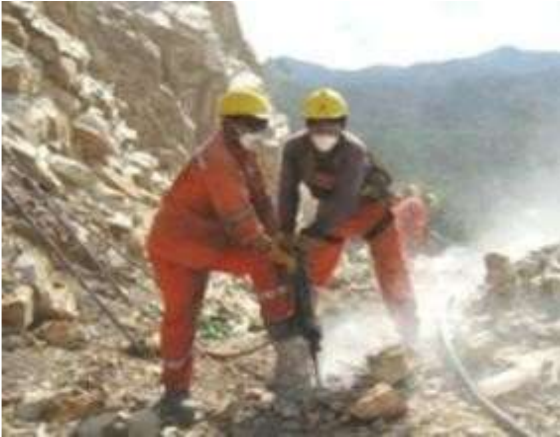
Ilustración 30: Perforación de taladros.
