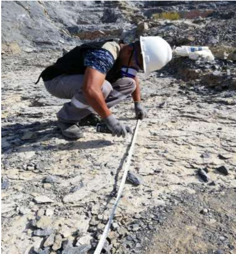
Ilustración 10: Marcado de malla de perforación y voladura de rocas.
