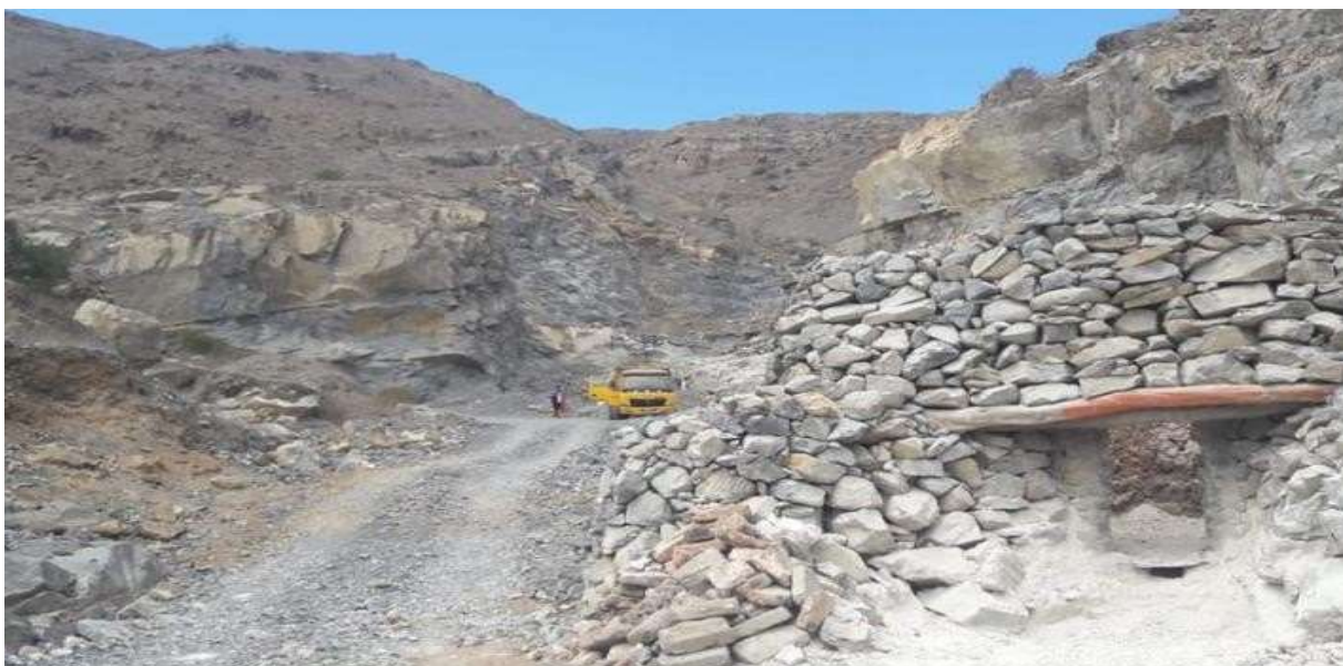
Ilustración 22: Acceso unió hacia la cantera PROVEN III
