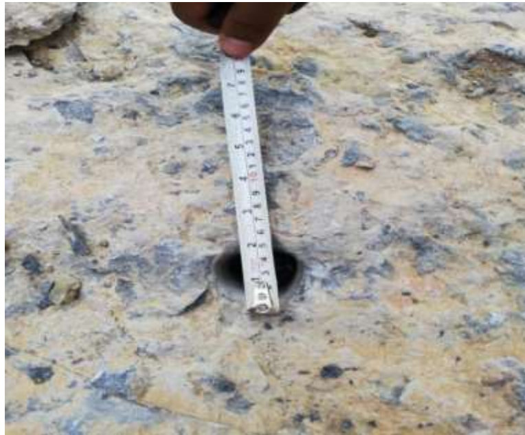
Ilustración 8: Evaluando el diámetro de la perforación.
