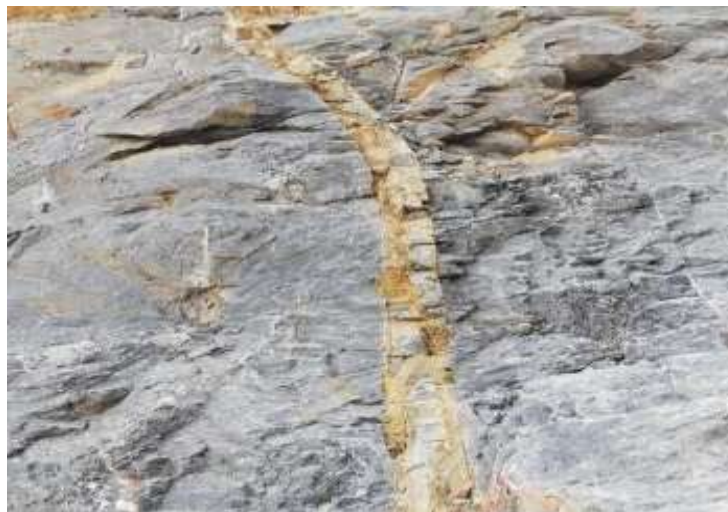
Figura N° 32: Caracterización in situ del material rocoso.
