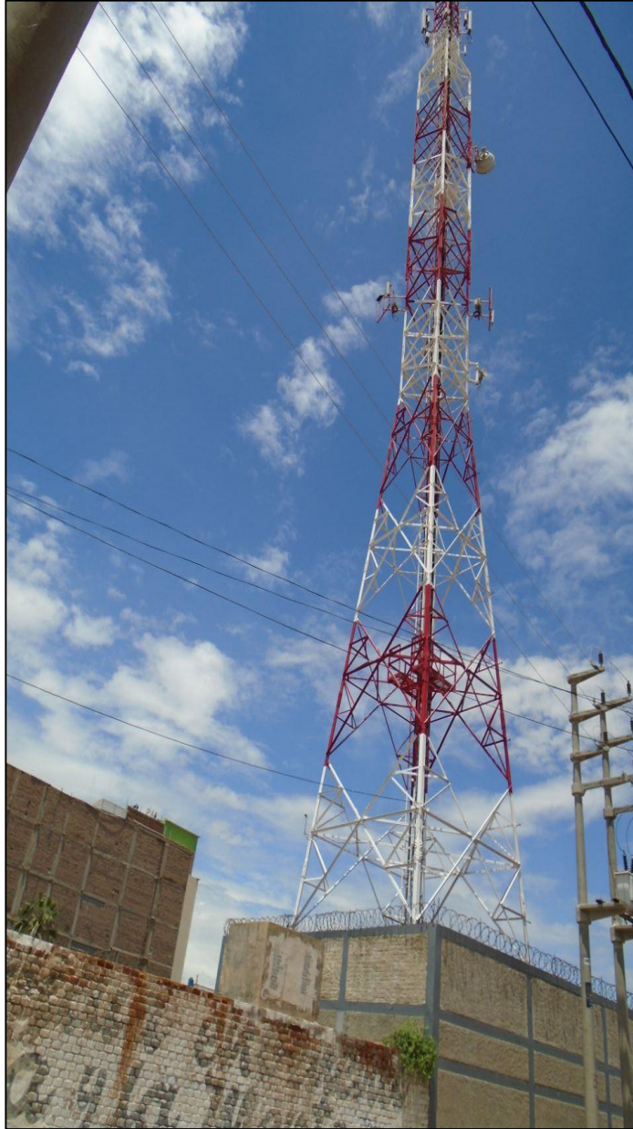
Figura III-3: Vista General de la Torre LA_Pimentel.
