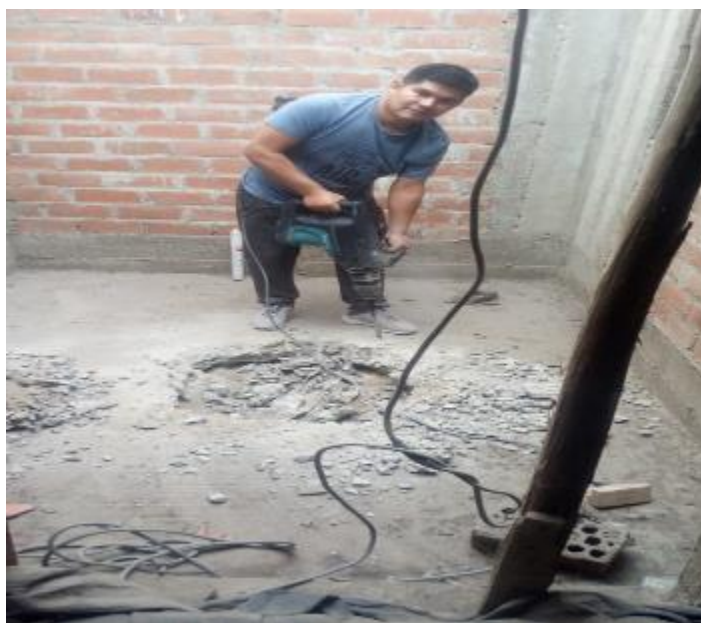
Imagen No. 1. Perforación del piso para calicata.
