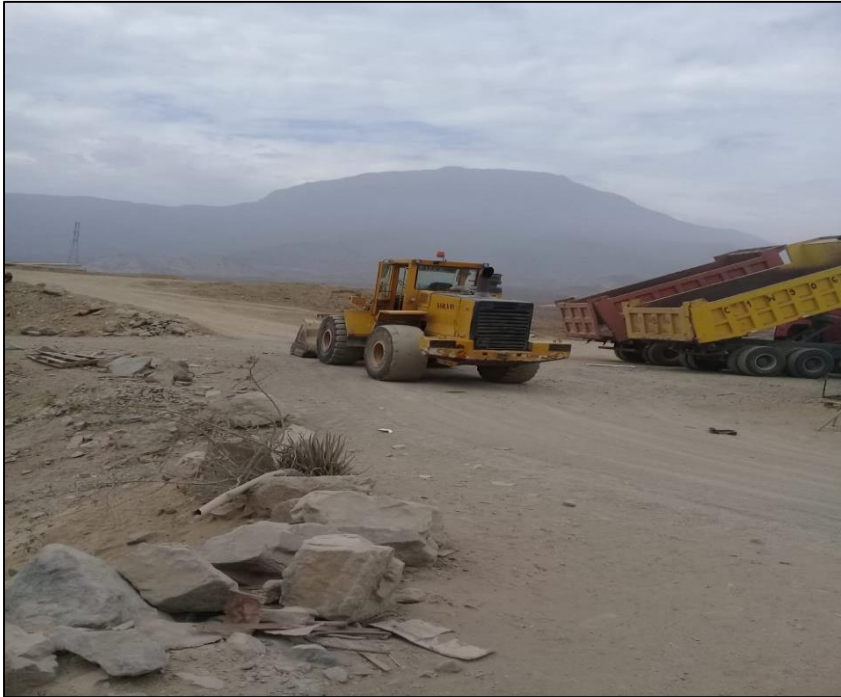
Gráfico 25. Maquinarias para la extracción de agregados.
