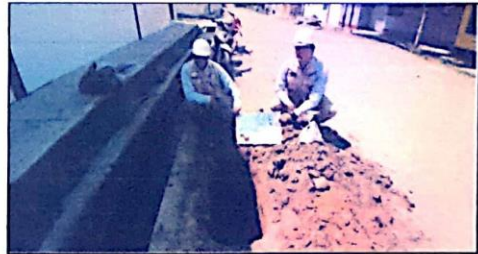
SE OBSERVA CALICATA EXCAVADA N° 03 (JR. LIBERTAD CDRA. 07), PERFIL ESTRATIGRÁFICO DEL TERRENO Y EXTRACCIÓN DE MUESTRAS PARA LOS ENSAYOS DE LABORATORIO DE MECÁNICA DE SUELOS
