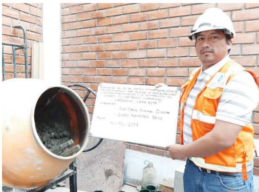
FOTO 3: Realizando la mezcla del concreto
