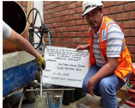
FOTO 4: Ensayo del Asentamiento para verificar el slump del concreto
