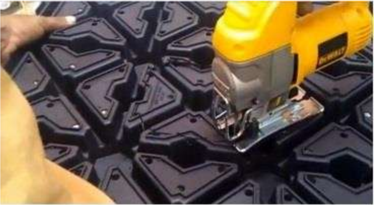
Figura N° 07. Capa drenante usado en azotea verde en la ciudad de Caracas Fuente: Revista SLT Caucho
