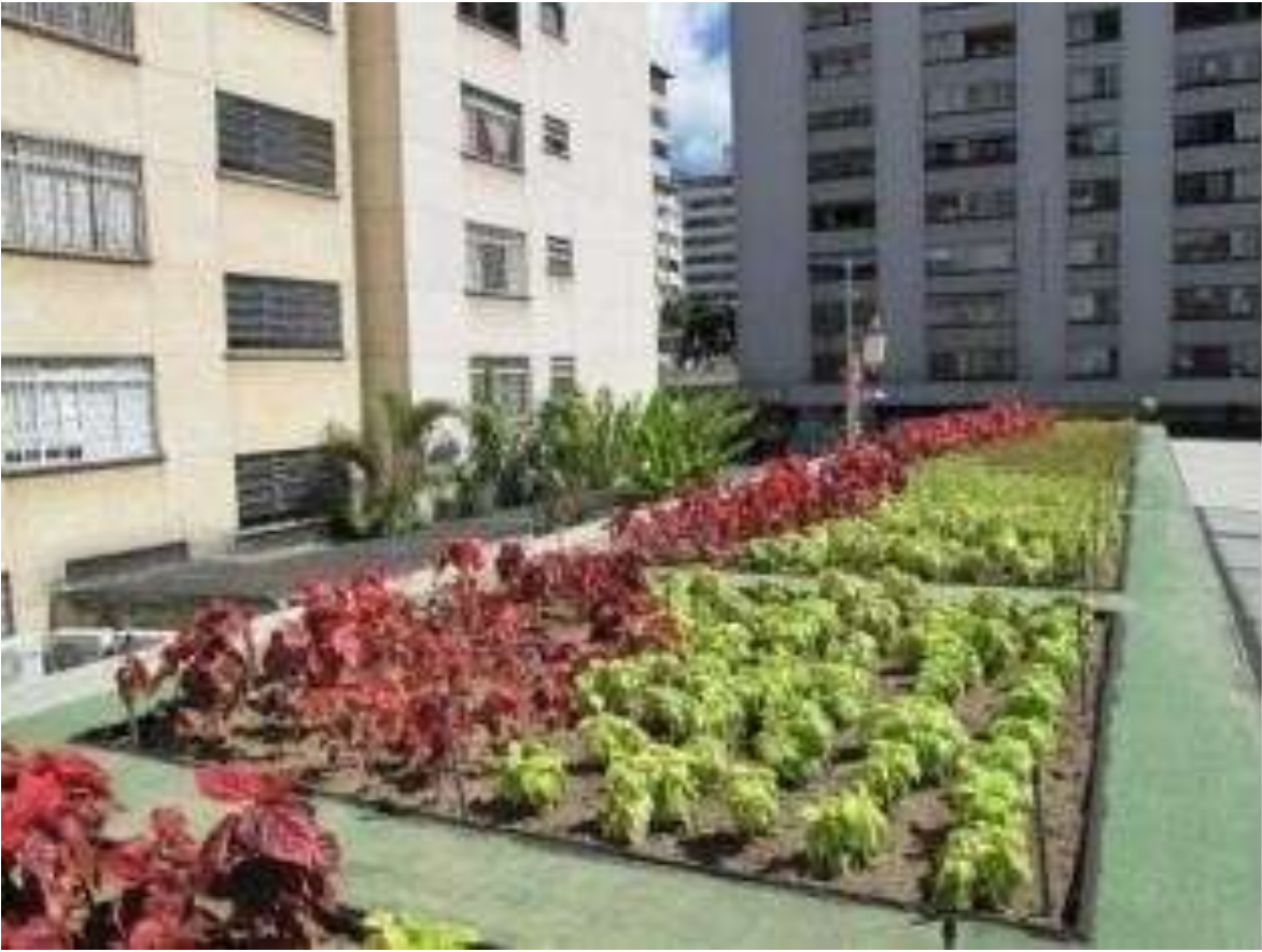
Figura N° 11. Retenedor Perimetral con brocas en la ciudad de Caracas Fuente: Blog Techos Verdes
