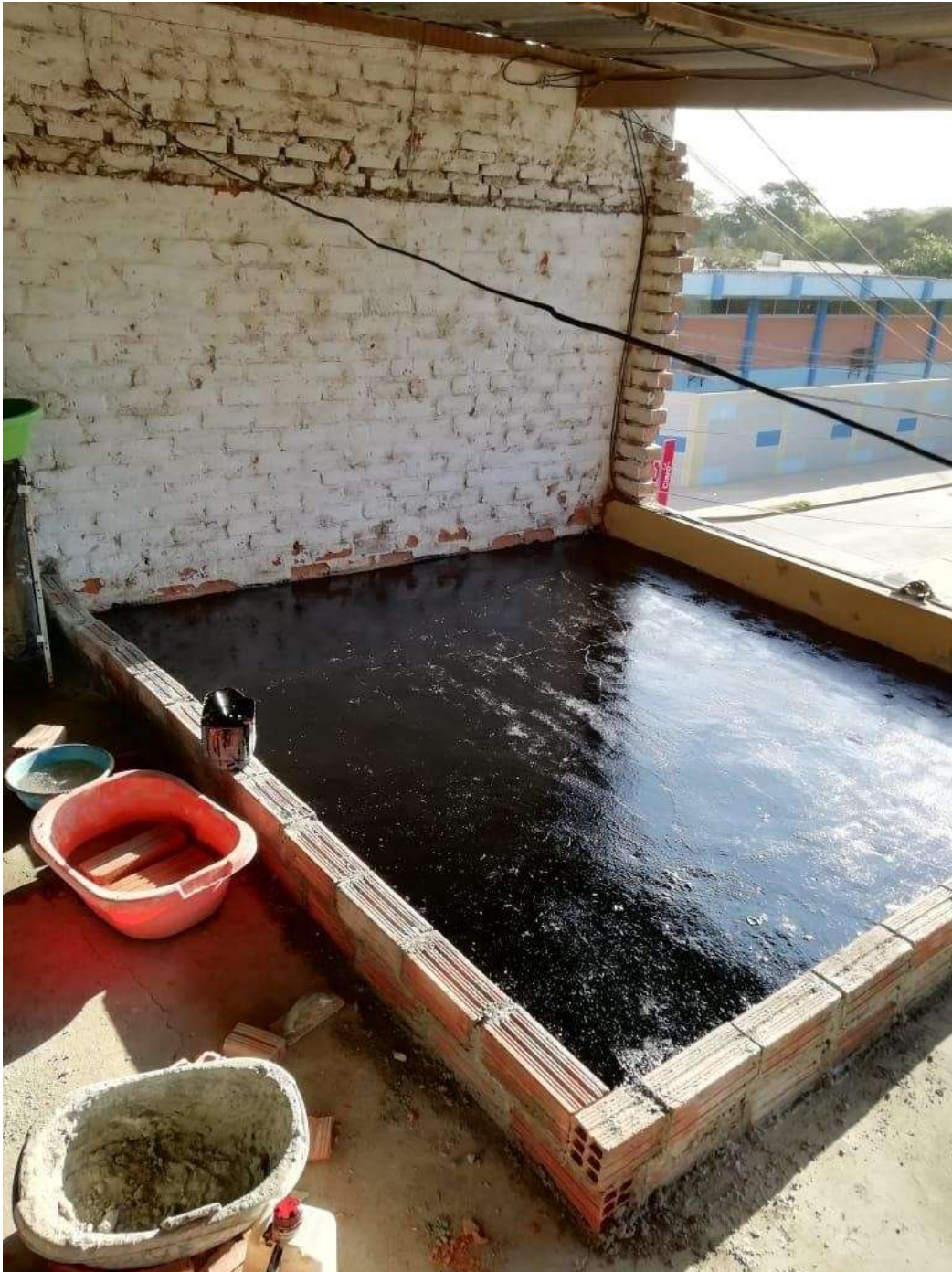
Figura N° 16: Pintura Impermeabilizante Fuente Propia
