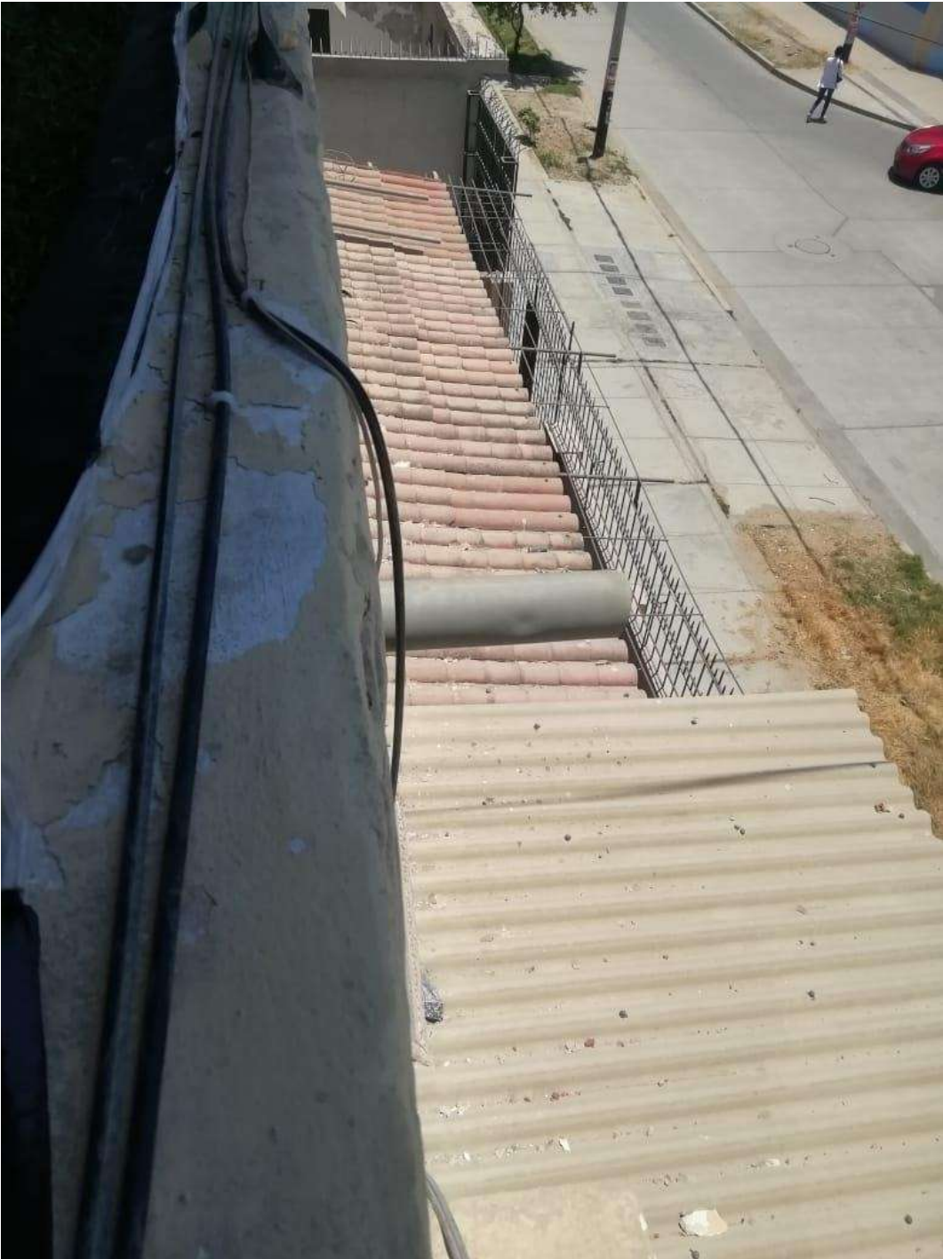
Figura N° 18: Implementación del sistema de desagüe Fuente Propia
