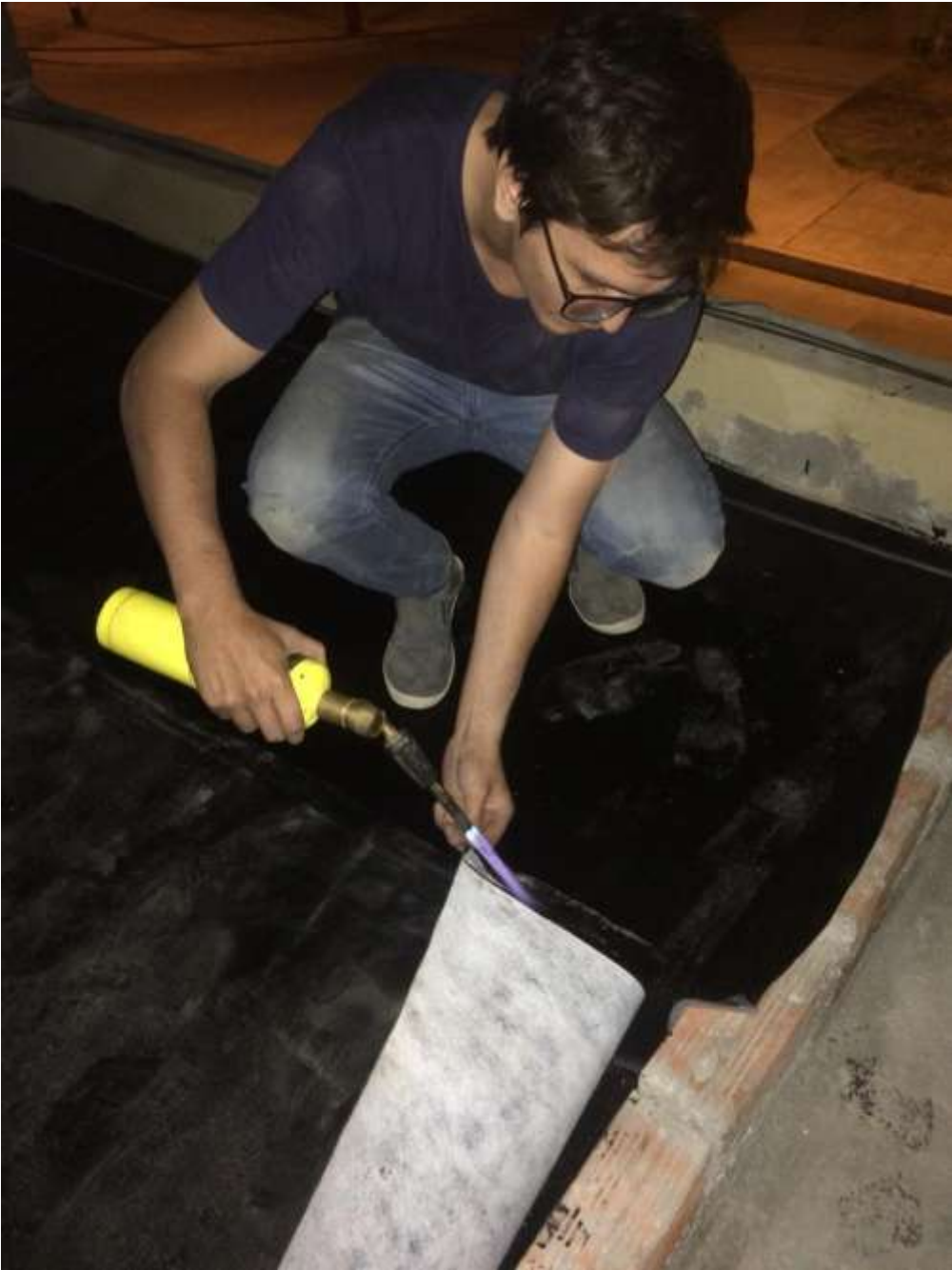
Figura N° 17: Implementación de Geotextil implementado Fuente Propia
