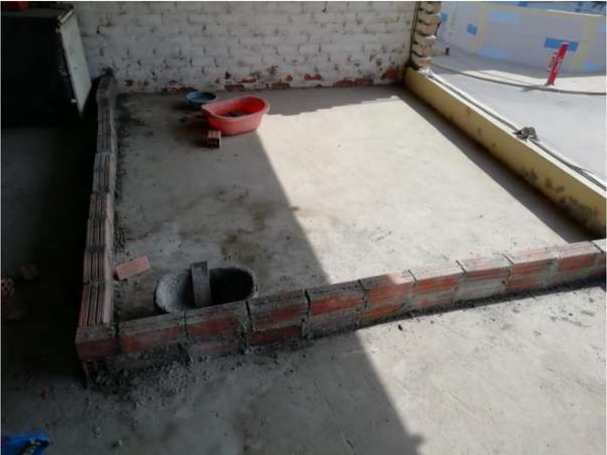
Figura N° 15: Realización del retenedor perimetral Fuente Propia
