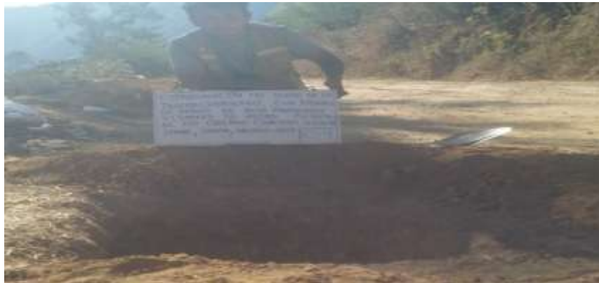
Elaboración de calicata N° 4
