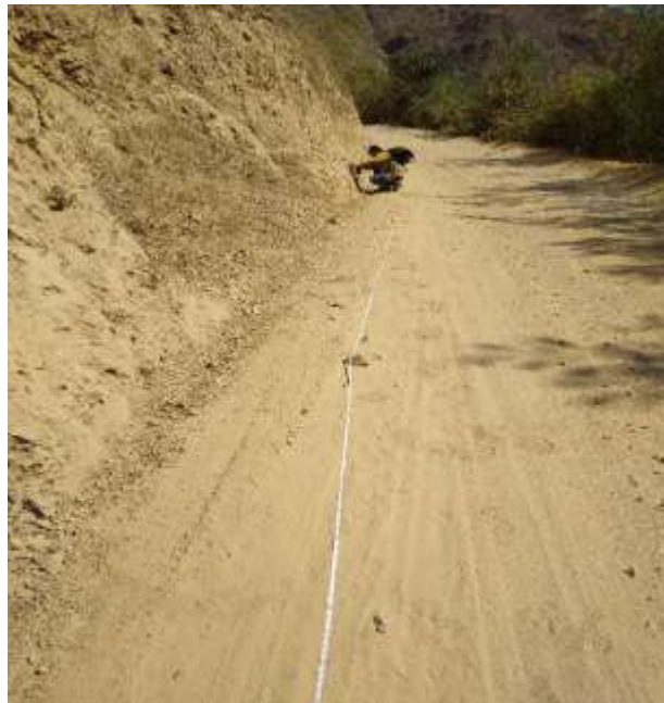
Medición de las separaciones de las progresivas
