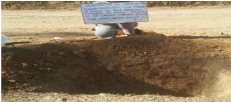
Elaboración de calicata N° 3
