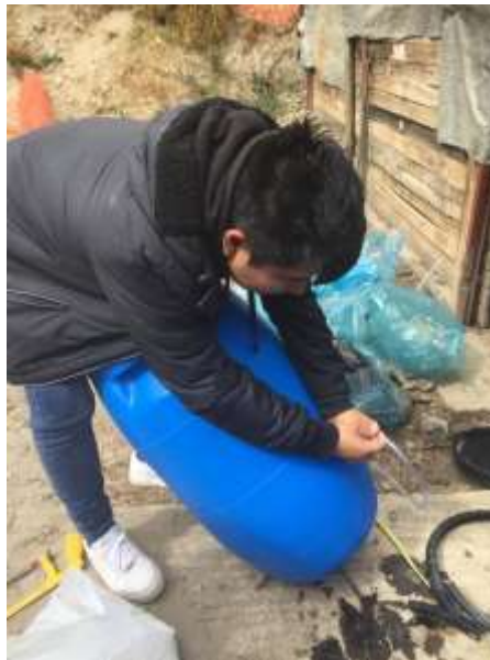
Imagen 2. Construcción de los Biodigestores
