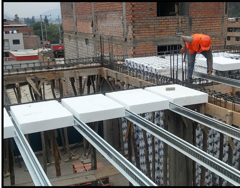
Figura 2: Sistema Pre-fabricado losa aligerada VIGACERO
