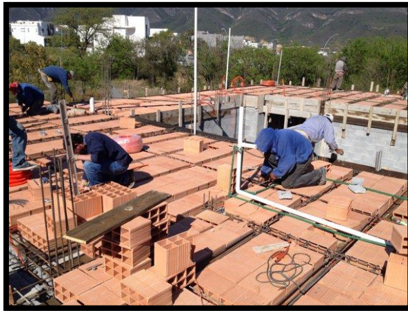
Figura 3: Sistema de los aligerada Convencional
