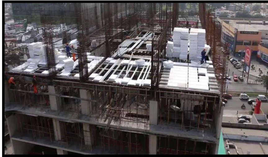
Figura 1: Construcción con VIGACERO
