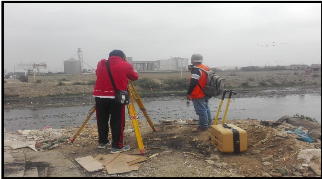
Figura 48 Instalación de Estación Total
