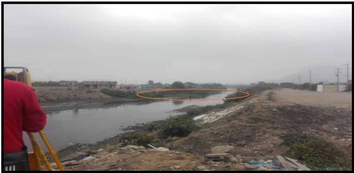
Figura 3 Progresiva 0+000 (Primer punto levantado).
