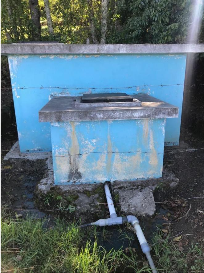
*El reservorio existente en el sector, se encuentra en un mal estado, es evidente la falta de mantenimiento y limpieza de dicho reservorio, además se puede evidenciar que presenta con muchas grietas, las cuales son un peligro pues deja en evidencia que el reservorio puede fallar en un futuro.*
