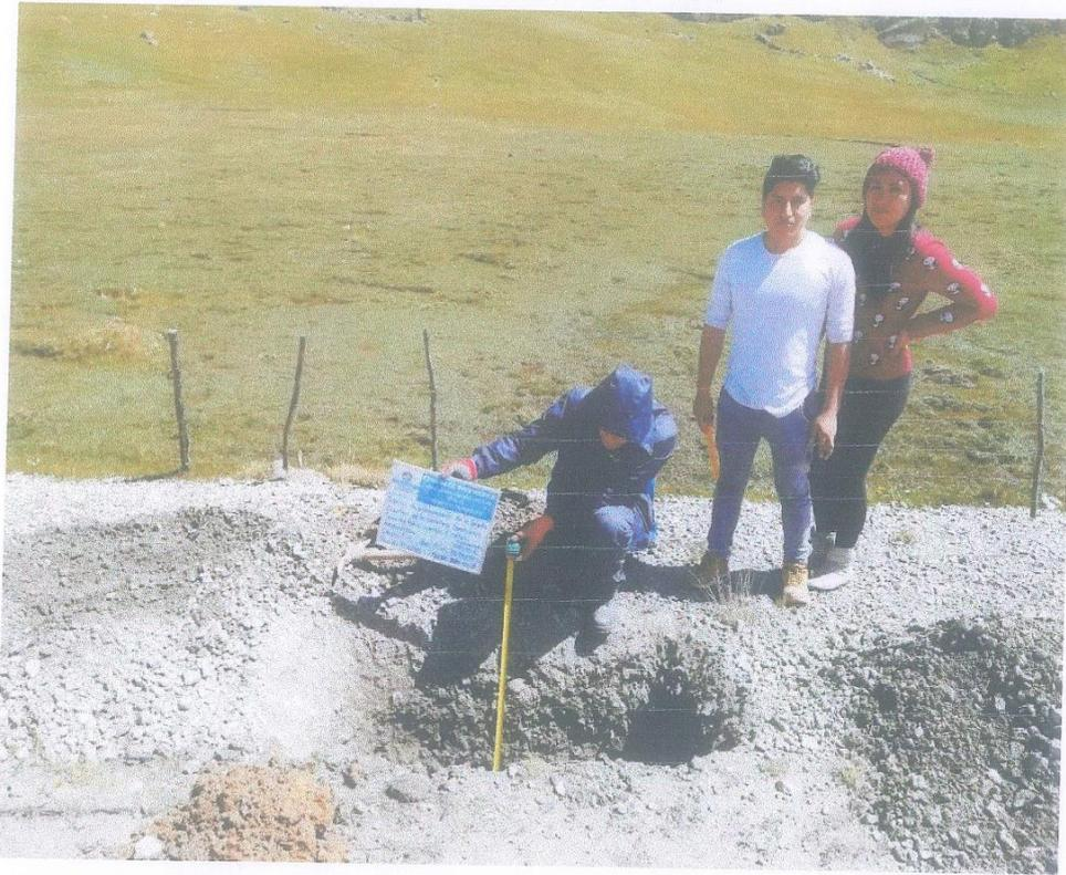
**FOTOGRAFÍA 4: VISTA DE LA EXCAVACIÓN DE LA CALICATA C-2 DONDE SE EXTRAJO LA MUESTRA PARA LOS RESPECTIVOS ENSAYOS SOLICITADOS, PARA EL PROYECTO "ANÁLISIS DE LA DEGRADACIÓN DE LA CARPETA ASFÁLTICA DE LA CARRETERA YANAHUANCA, CERRO DE PASCO, USANDO EL MÉTODO MECANISMO" A UNA PROFUNDIDAD DE H=1.50M / FOTOGRAFÍA REMITIDA POR EL LABORATORIO.**
