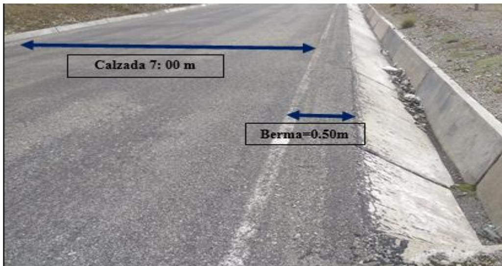
Figura N° 7 – Ancho de calzada y berma.
