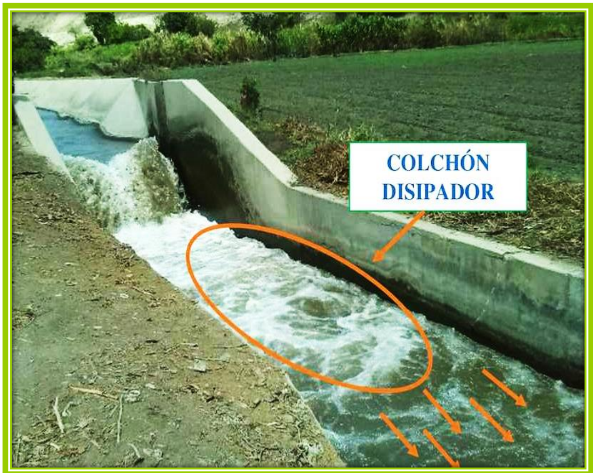
Figura 08. Colchón disipador.
