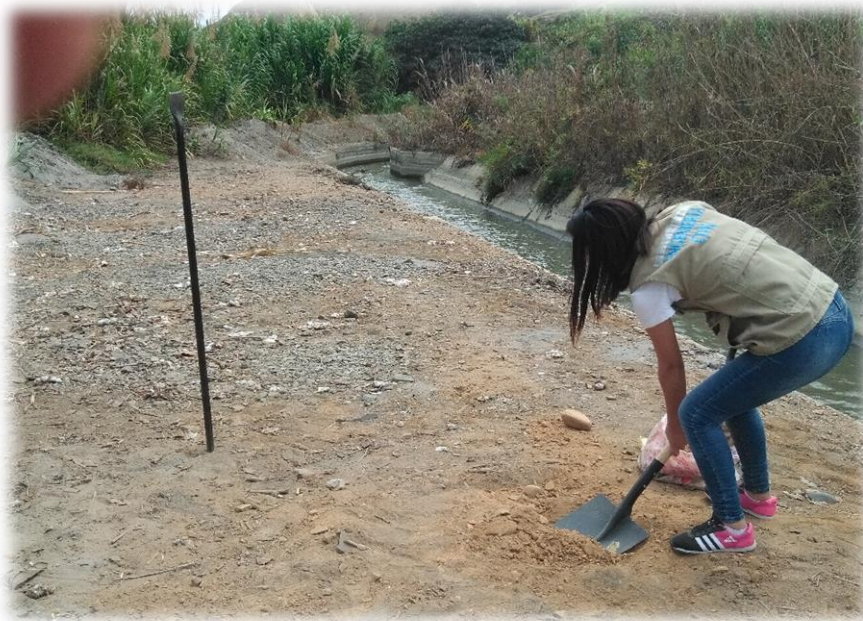
En la imagen se aprecia el comienzo de las excavaciones de las calicatas.
