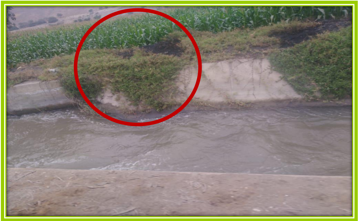
Figura 07. Vegetación que presenta en el canal.
