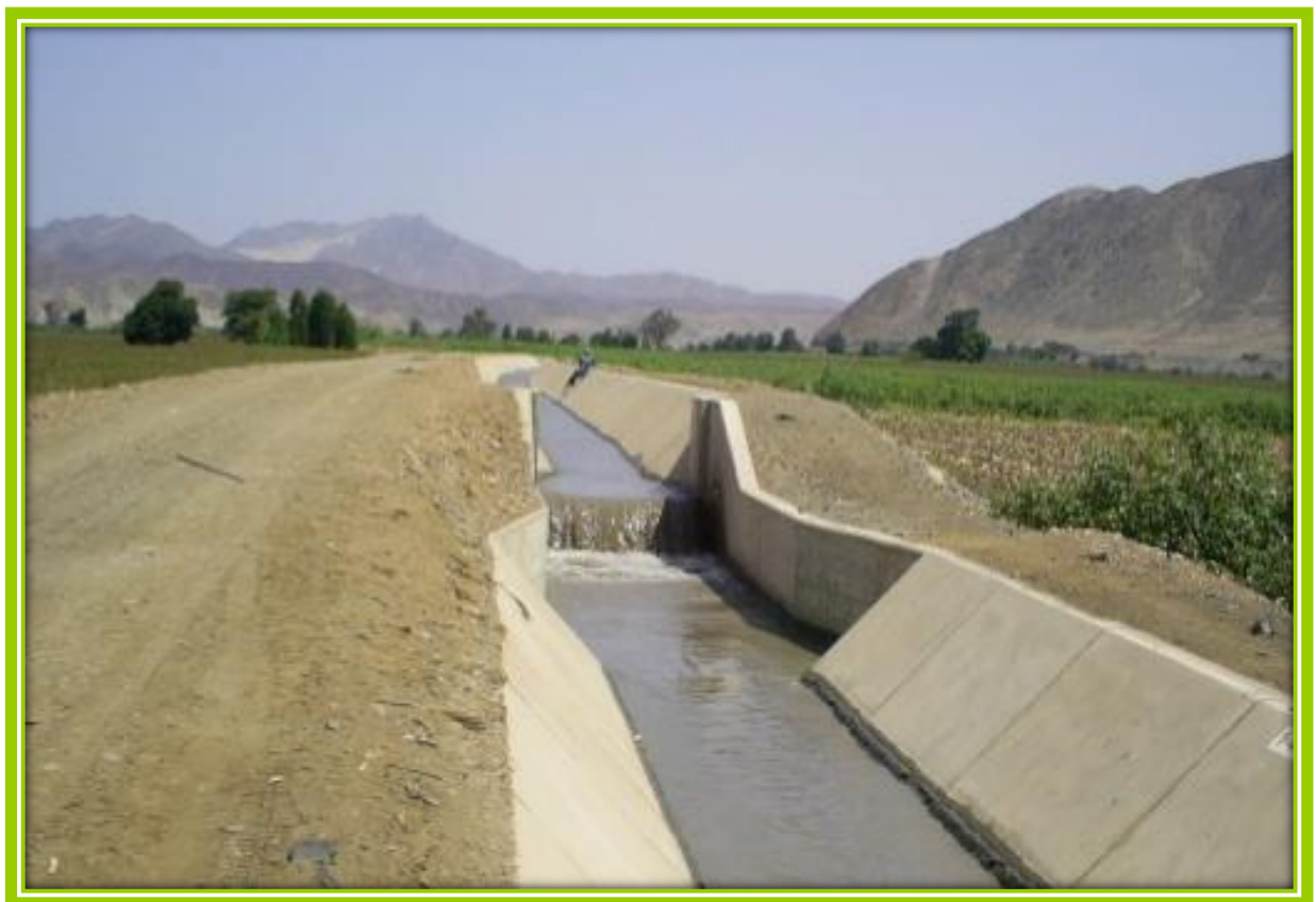
Figura 12. Canal Santa – San Bartolo.
