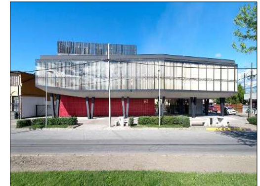
Figura: Frontis del edificio Fuente: Sunearthtools
