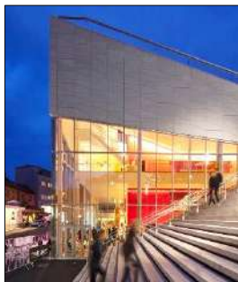
Figura: Fachada Lateral Izquierda Fuente: Google
