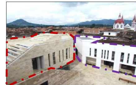
Figura: Fachadas de Aulas de Ensayo + Biblioteca Fuente: Archdaily
