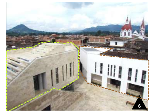
Figura: Fachadas de Aulas de Ensayo + Biblioteca Fuente: Archdaily
