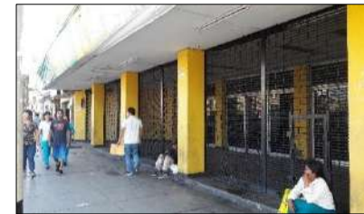
Figura: Circulación Pública – Hall ingreso Fuente: Propia
