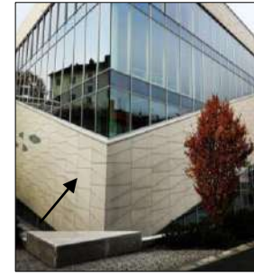
Figura: Fachada Lateral Izquierda Fuente: Google
