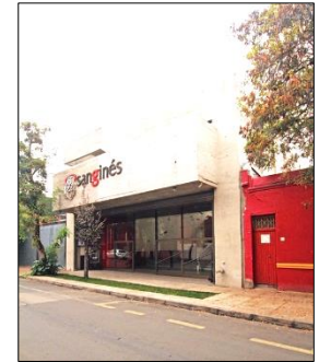
Figura: Ingreso Principal al Centro Cultural Fuente: Archdaily
