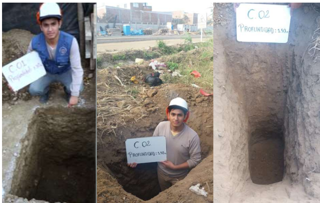
Figura 14. Ubicación de las calicatas 1 y 2
