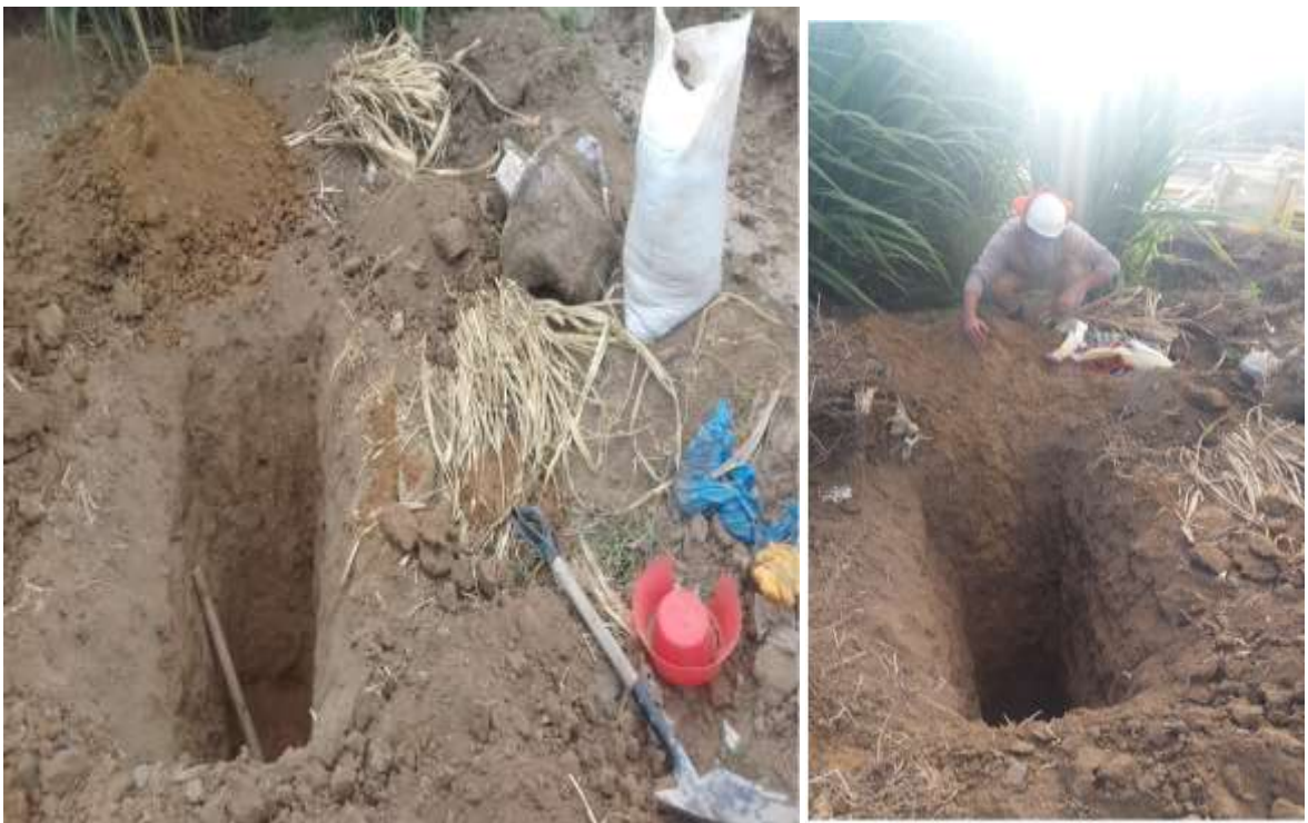
Figura 30. Implementos y lugar de excavación de las calicatas.
