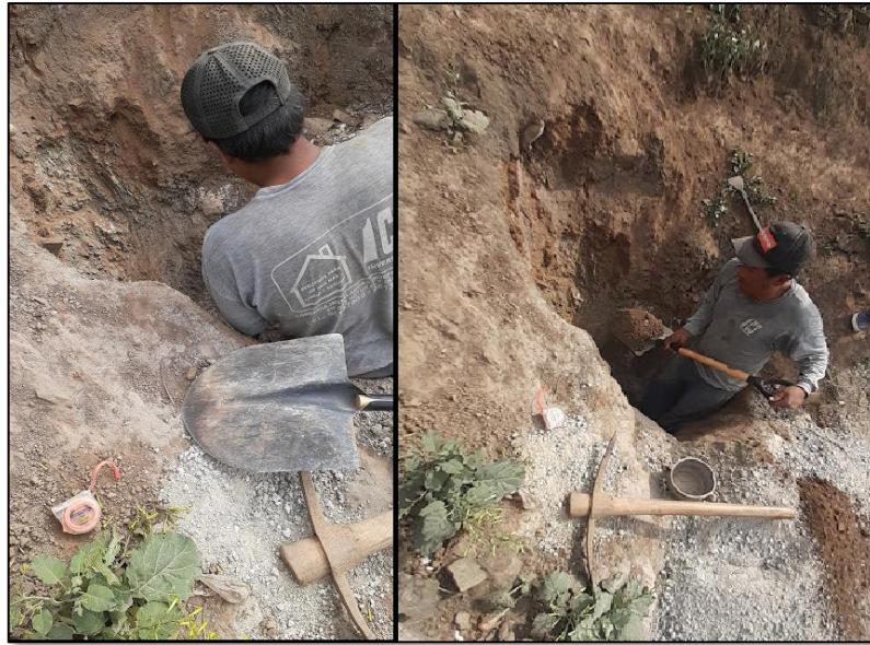
Figura 24. Realización de calicatas
